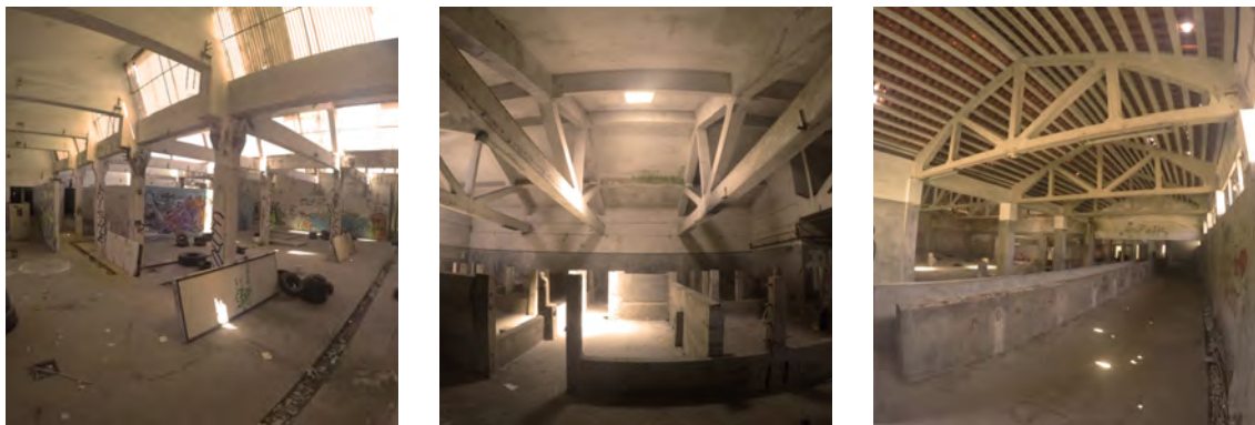
Fig. 40: Fotografias das coberturas existentes - shed e treliças
