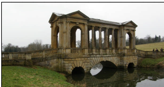
Fig. 51, Ponte Paladiana de Stowe. Fotografia.
