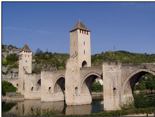
Fig. 41, Pont Valentré, Cahors.
