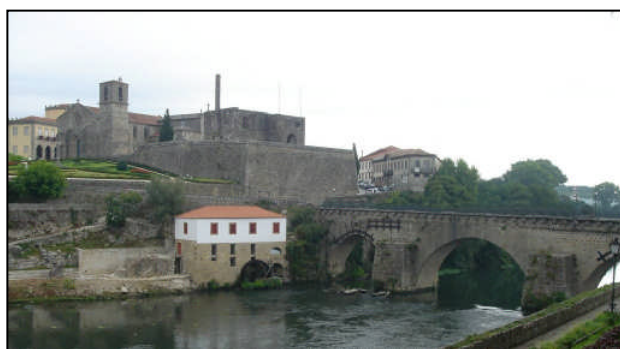
Fig. 194, Ponte sobre o Cávado, Barcelos.
