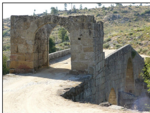
Fig. 192, Ponte de Sequeiros.
