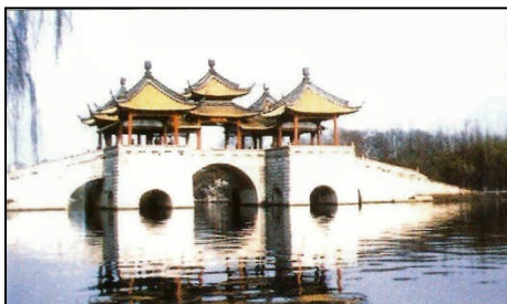
Fig. 225, Ponte Liahua (Flor de Lótus), ponte de pedra coberta em Yagzhou, China.
