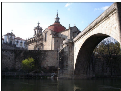
Fig. 208, Amarante, Ponte de São Gonçalo.
