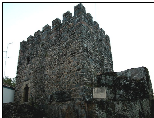
Fig. 205, Marvão, Torre da Portagem.
