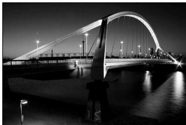
Fig. 9, Ponte La Barqueta de Santiago Calatrava, Sevilha, Espanha, 1989. Fotografia.
