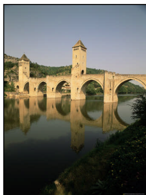
Fig. 216, Pont Valentré de Cahors, Fotografia.
