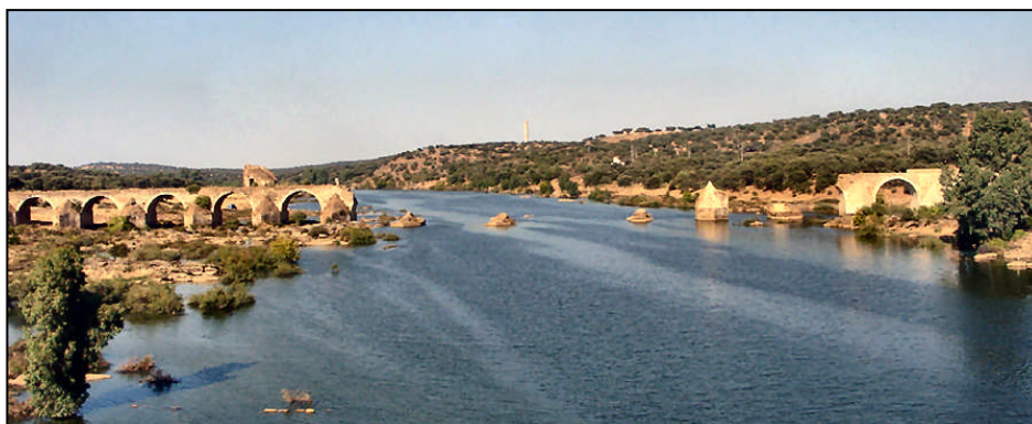
Fig. 206, Ponte de Nossa Senhora da Ajuda: Vista geral a jusante das ruínas da ponte.
