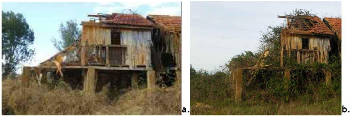
Figura 25 - Estado de Conservação do edifício número 14: a. Levantamento de 2014; b. Levantamento de 2016.
