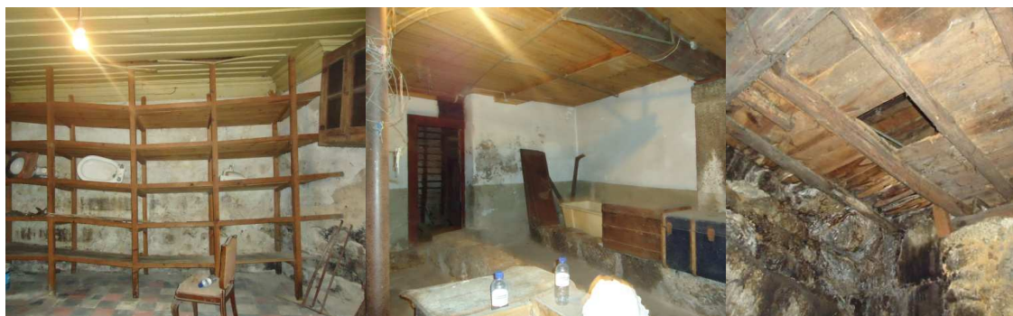
Foto 4.3 - Piso 0 do edifício
