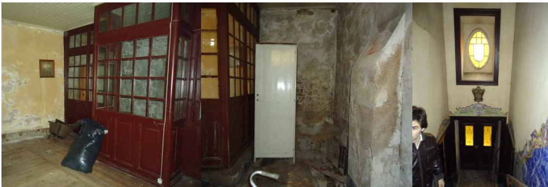
Foto 4.4 - Piso 1 do edifício
