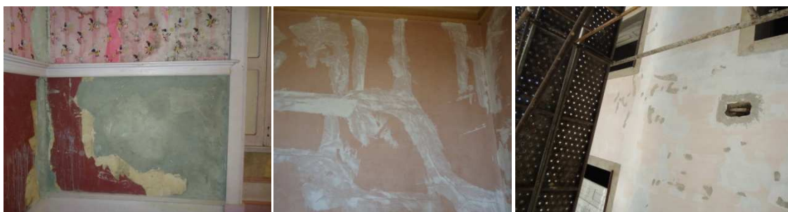
Foto 4.7 - Reparação das paredes e fachadas
