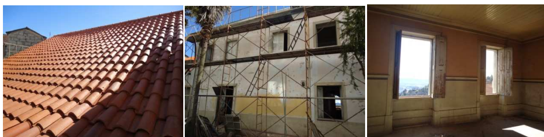
Foto 4.8 - Reparações no exterior e remoção das janelas
