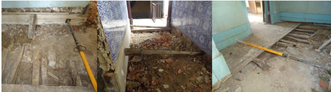
Foto 4.9 - Remoção das traves de madeira do pavimento
