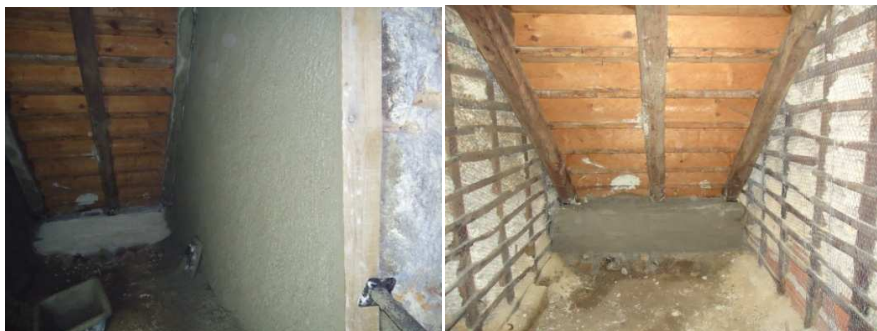
Foto 4.10 - Tratamento das paredes em contacto com a escadaria e reforço da base das escadas
