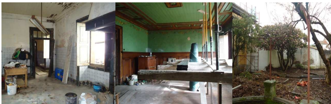
Foto 4.5 - Piso 2 do edifício e pátio
