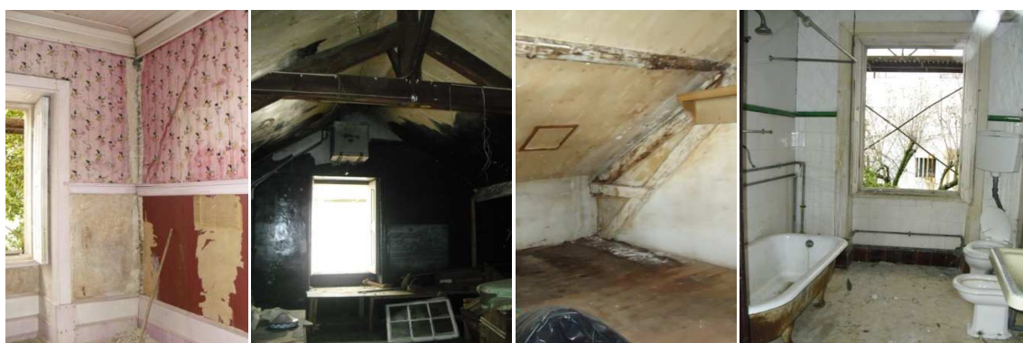
Foto 4.6 - Piso 3 do edifício
