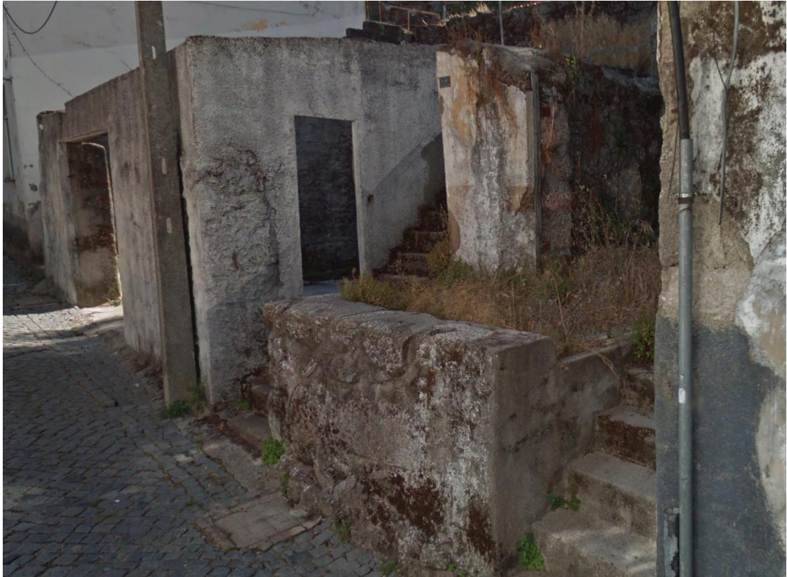
Imagem 41: Fotografia de casa em ruína, dentro do núcleo urbano, na Rua do Espírito Santo-Vila do Carvalho
