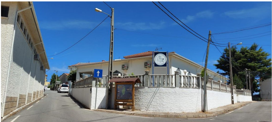
Imagem 65: Fotografia de Centro Social Nossa Senhora da Conceição, situado na Rua Júlio Morgado Durão Gomes-Vila do Carvalho.
