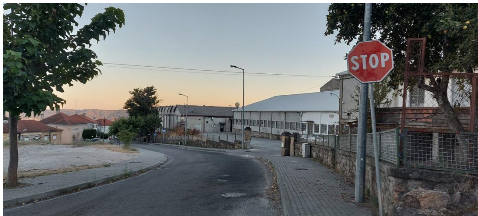
Imagem 30: Complexo de fábricas pertencentes à antiga “Lanofabrik”, União de freguesias Cantar-Galo e Vila do Carvalho.
