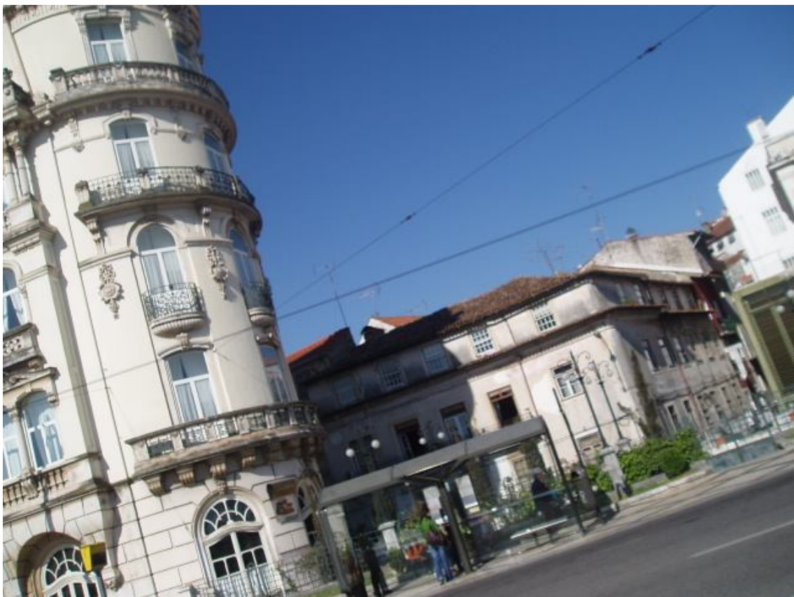
Figura 25, Vista sobre o Hotel Astória e sobre o edifício a intervir. Fotografia de Maria Monteiro, 2009.
