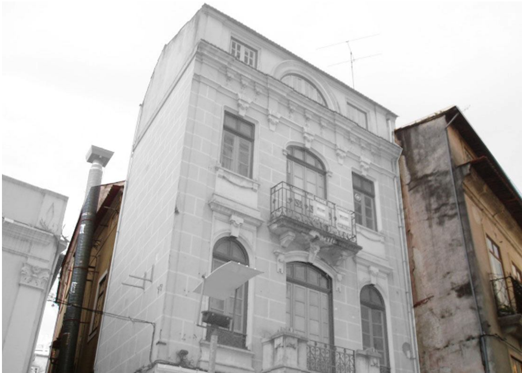
Figura 17, Envolvendo o edifício adjacente, Largo da Portagem, Coimbra. Fotografia de Maria Monteiro,2009.
