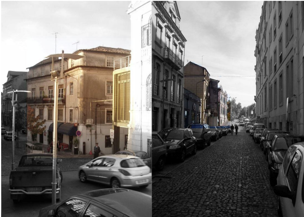
Figuras 14 e 15, Perspectiva do edifício, Galeria e restaurante (volume 1), Largo da Portagem, Coimbra. Fotografia de Maria Monteiro, 2009.
