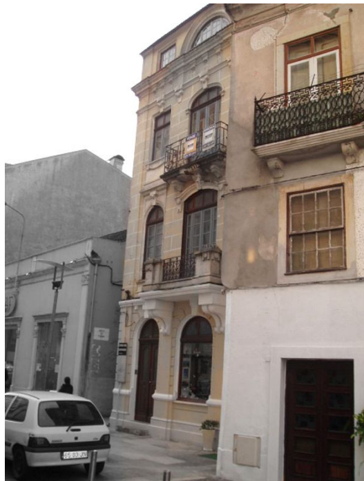
Figura 16, Edifício adjacente Oeste da Galeria e restaurante (volume 1), Largo da Portagem, Coimbra. Fotografia de Maria Monteiro, 2009.
