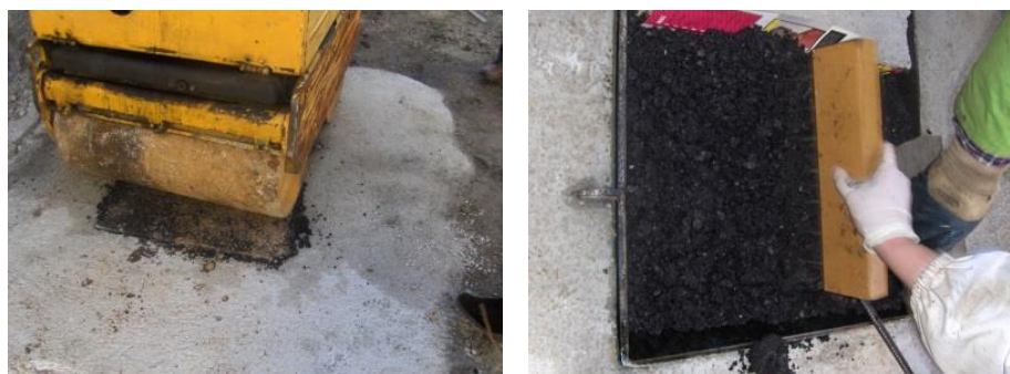
Figura 5.17 - Produção e compactação da lajeta com o cilindro de rolos
