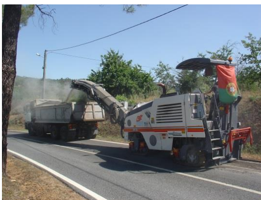
Figura 5.5 - Pavimento do troço da EN346 em processo de fresagem
