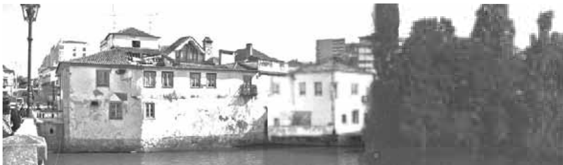
Fig.28 - Fachada Oeste do Convento de Santa Iria.
