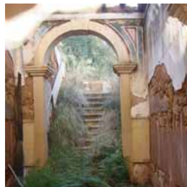
Fig.56 - Acesso ao interior
