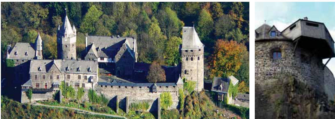
Fig.5 - Primeiro Hostel, Altena-Alemanha
