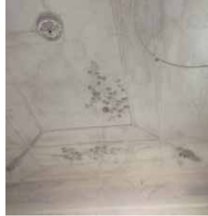
Fig.50 - Detalhes dos tetos
