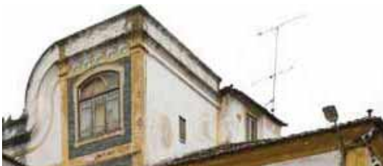
Fig.33 - Fachada Este (Torreões)
