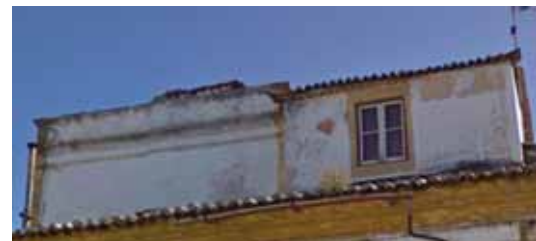
Fig.34 - Fachada Norte (Torreões)
