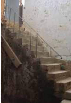
Fig.48 - Acesso ao 2º piso
