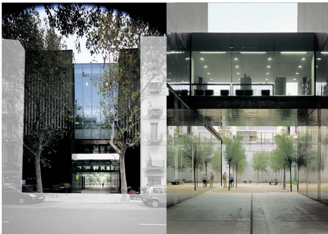
Figura 27 a) - 'Fachada-porta'; Figura 27 b) - Túnel de acesso ao interior do quarteirão, biblioteca no corpo elevado.
