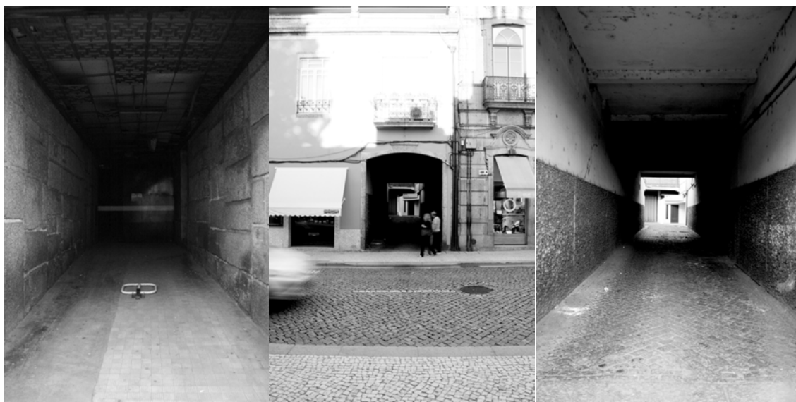
Figura 73 a) - Vista do interior do túnel do edifício nº14 da Rua Paio Galvão; Figura 73 b) - Vista a partir da Rua Paio Galvão para o túnel do edifício nº 8 da Rua Paio Galvão; Figura 73 c) - Vista do interior do túnel do edifício nº8 da Rua Paio Galvão.
