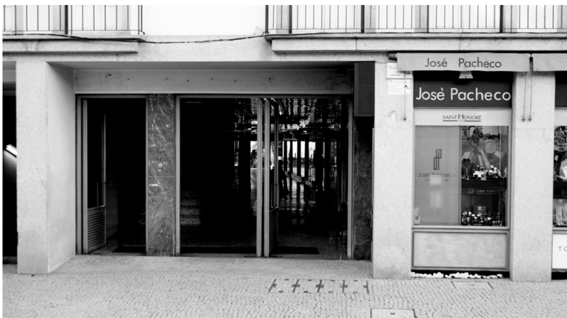
Figura 72 - Vista a partir da Rua de Santo António, para o túnel do edifício nº36.
