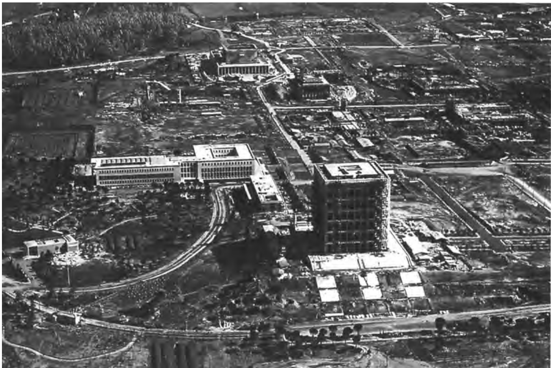
Fig. 7 E42 em construção
