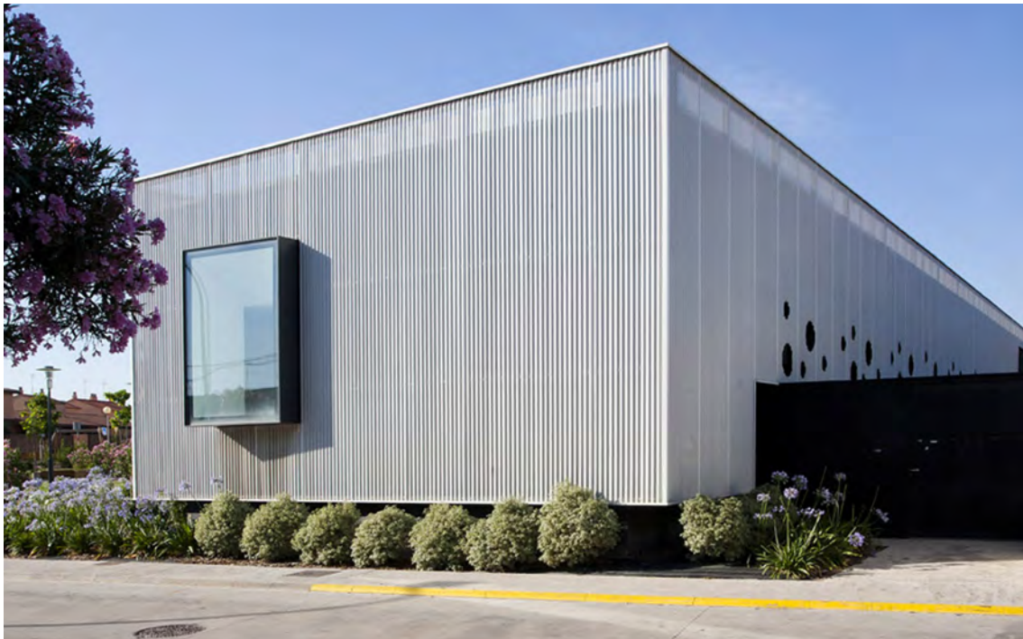
Fig. 90 Exemplo de um edifício revestido a chapa ondulada micro perfurada (Consultório Médico Cortez)
