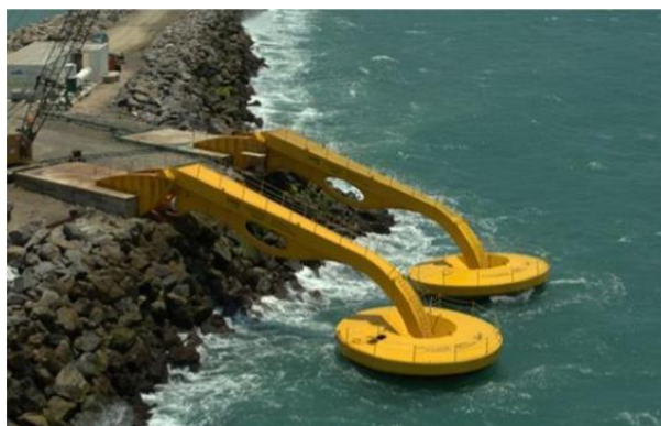
Figura 2.12 - Central piloto no Porto de Pecém - Ceará [7].
