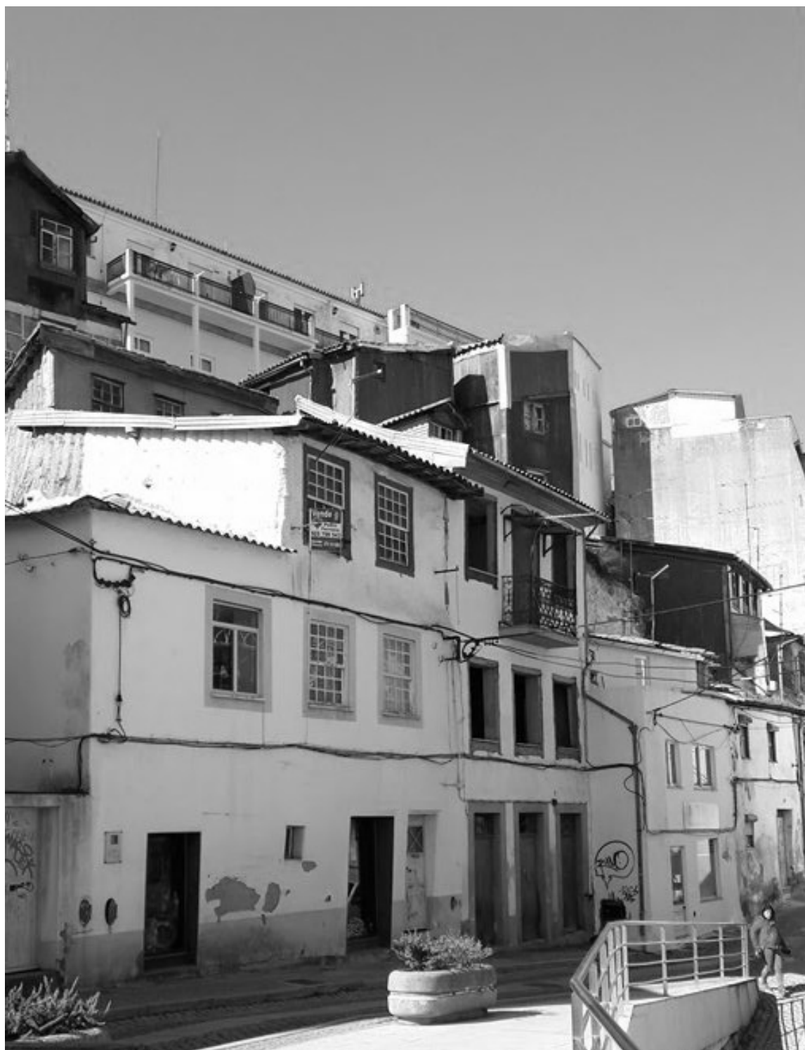
Figura 3.0.0 - Habitação inserida na malha urbana, Covilhã
