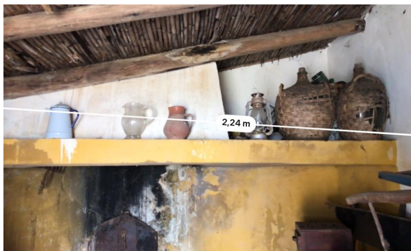
Figura 23 – Interior de habitação em Cachopo
