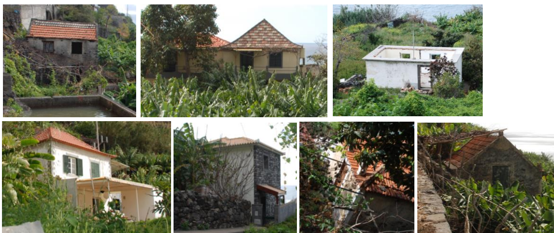
Imagem 129 - Edifícios n° 1 a 7
