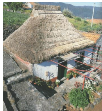
Imagem 69 - Casa elementar de cobertura de palha e paredes de alvenaria, Canhas, Ponta de Sol
