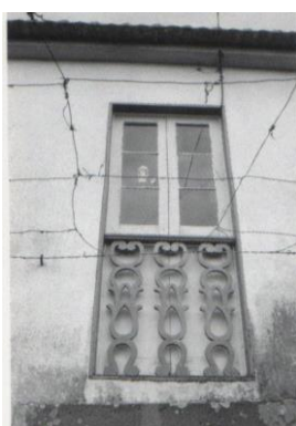
Imagem 108 - Janela-varanda, Ponta Delgada (Madeira)
