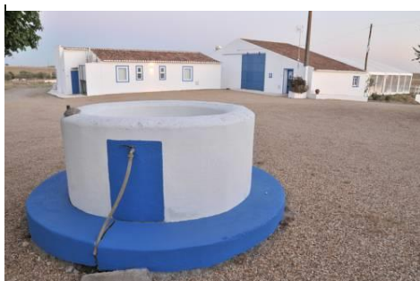
Imagem 35 - Casa do Barreiro, Ponte de Lima
