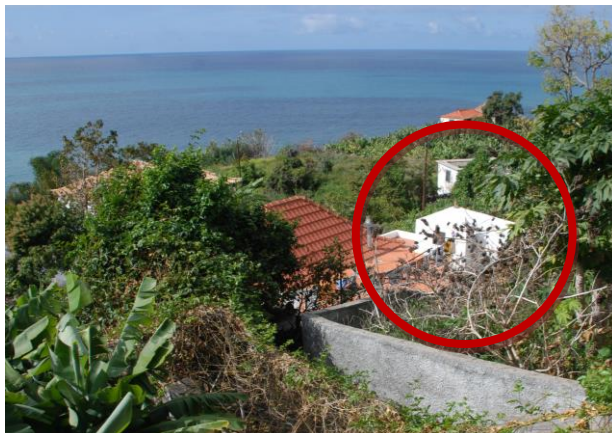
Imagem 134 - Anexo edifício nº4
