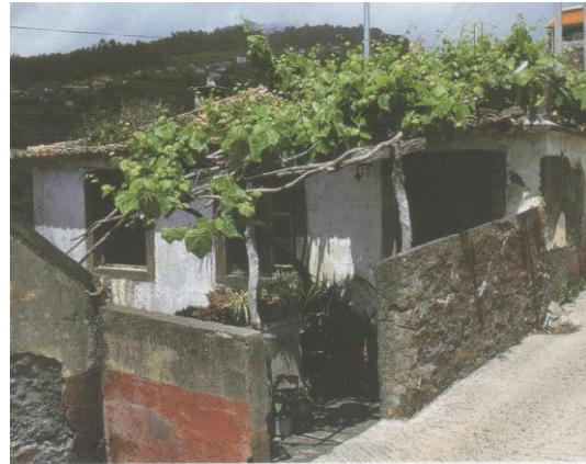
Imagem 79 -Casa elementar de cobertura cerâmica, Lombo do Doutor, Calheta
