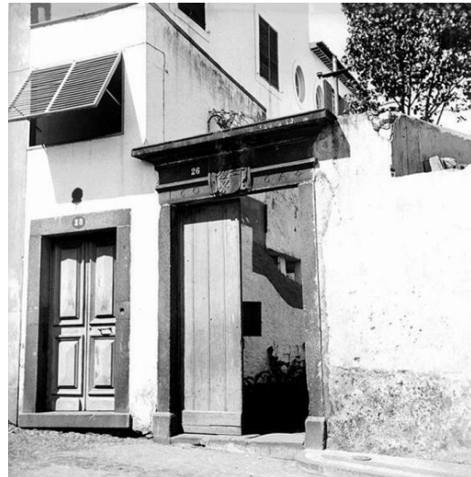
Imagem 101 - Entrada do Solar Dona Mécia em cantaria (1940), Funchal
