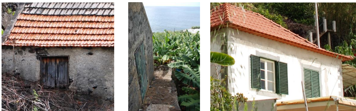
Imagem 137 - Pormenores dos edifícios n.º 1, 7 e 4
