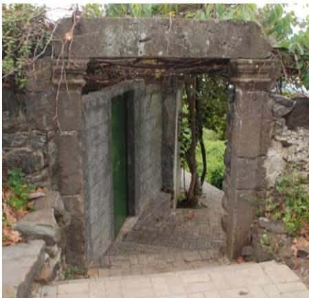
Imagem 133 - Anexo edifício nº 6
