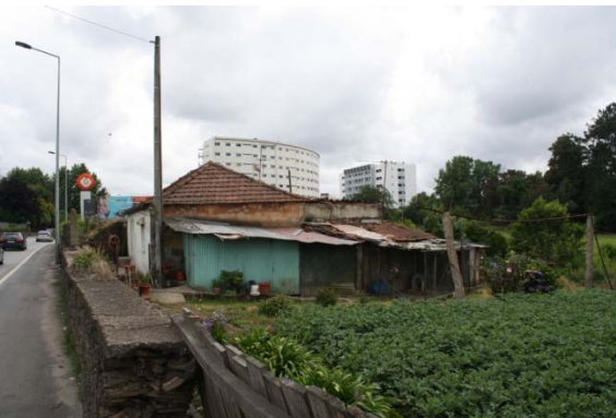
Figura 10 – Habitação em estado de degradação na área de estudo. (Fonte 10)
