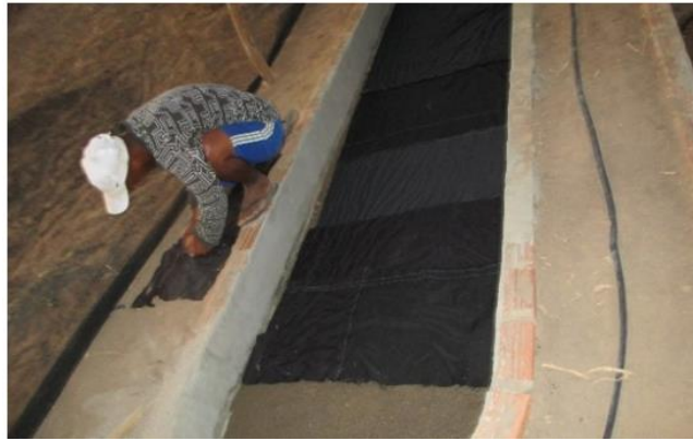
Figura 70 – Canteiro 3D, em processo de construção.
