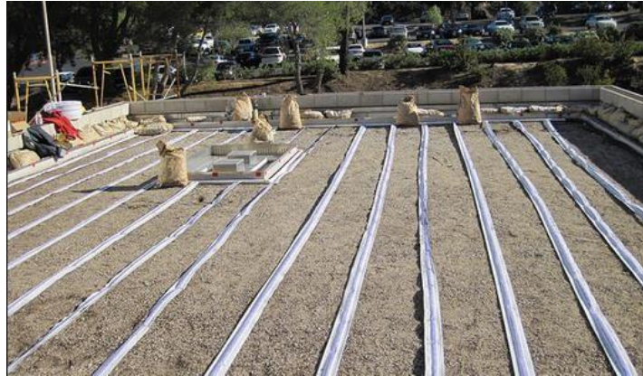
Figura 13 – Irrigação subterrânea por gotejamento e capilaridade subterrâneos. (Fonte: [2])
