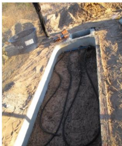
Figura 66 – Construção do canteiro 3B.
