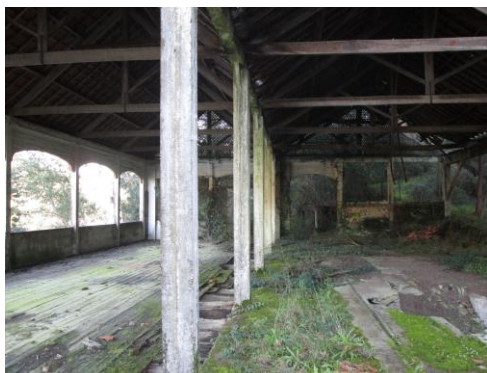
FIG.58 - vista da nave central e terceira nave.
