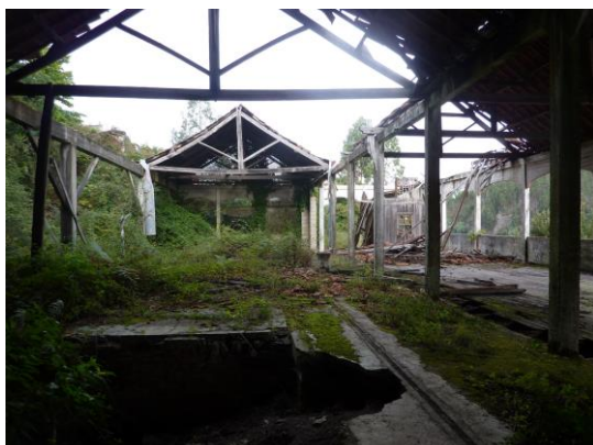
FIG.56 - Vista da nave central.
