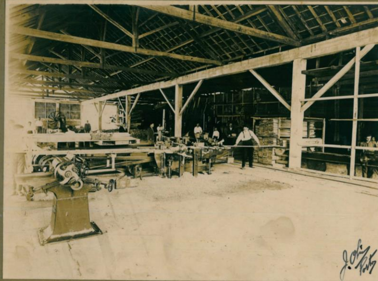
ASPECTO GERAL DAS MÁQUINAS
