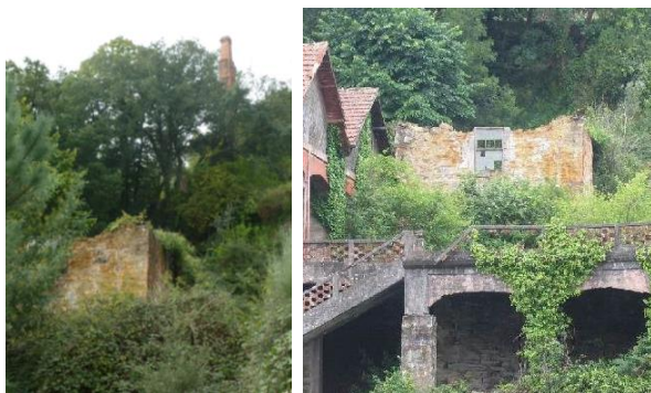
FIG.53 - Casa das máquinas.
