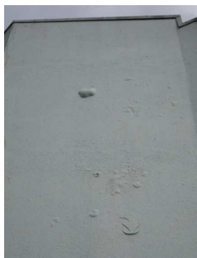
Figura 87 - Empolamento da tinta exterior. [59]
