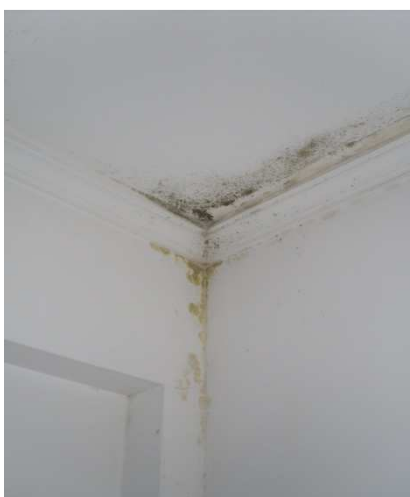
Figura 128 - Humidades nos cantos superiores dos compartimentos. [59]
