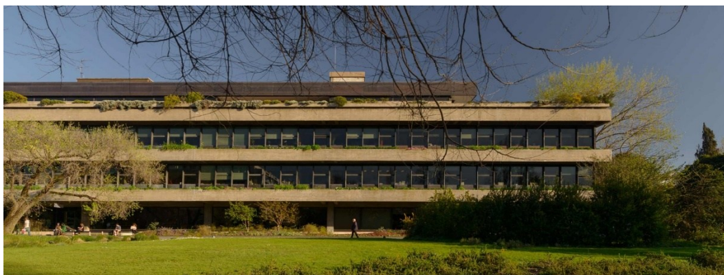
Figura 25 - Fundação Calouste Gulbenkian, Lisboa: fachada principal do edifício sede, caracterizada pela integração de canteiros contínuos em betão armado, que acolhem vegetação e transformam a fachada numa extensão da paisagem. («Fundação Calouste Gulbenkian»)
