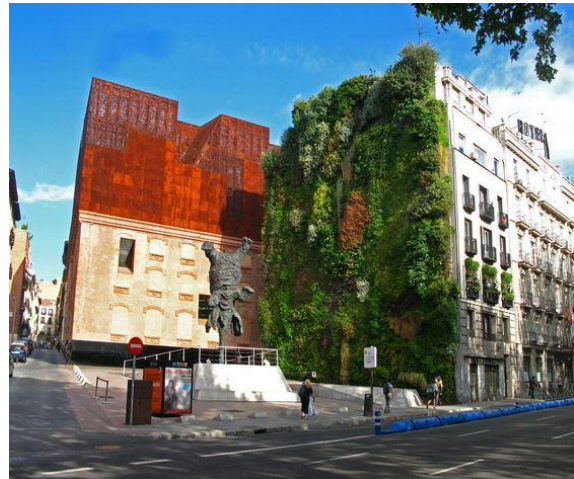
Figura 12 - Parede verde da Caixa Fórum, Madrid, de Patrick Blanc (2008)
