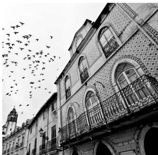
Figura 4 - Fachada, zona histórica de Leiria (2013)
