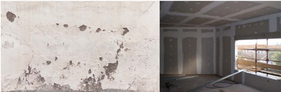
Figuras 34 e 35: Paredes em adobe e espaço interior em gesso cartonado;
