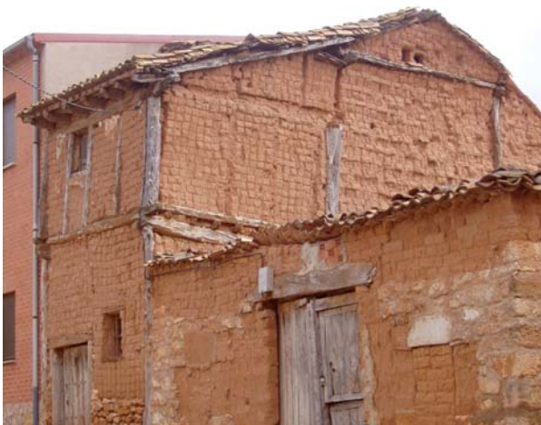
Figura 22: Paredes em adobe;
