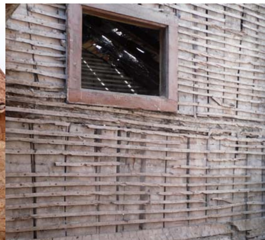
Figura 23:Paredes em tabique;
