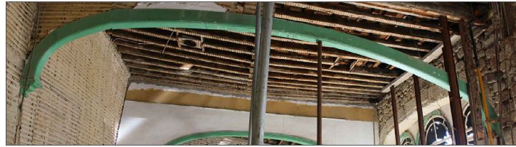
Imagem 195 - Levantamento fotográfico do Arco V3
