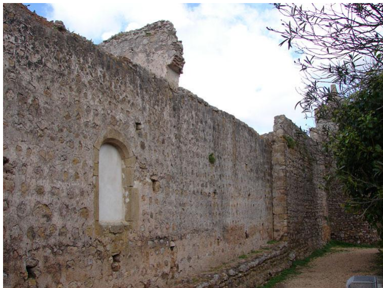
Foto 2 – Vista exterior da muralha da Alcáçova
