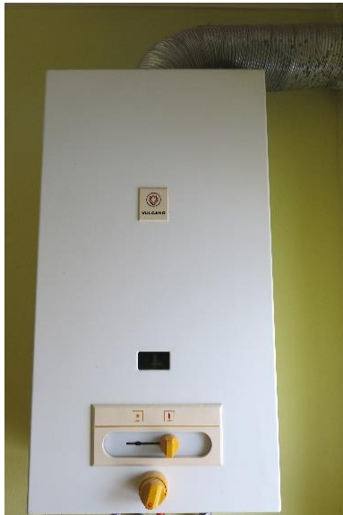
Figura 5.31 Esquentador VULCANO, modelo WR275-1 de 11l, no caso de estudo 3.
