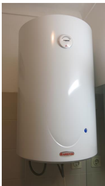
Figura 5.38 Termoacumulador modelo TI 80 R P, no caso de estudo 4.
