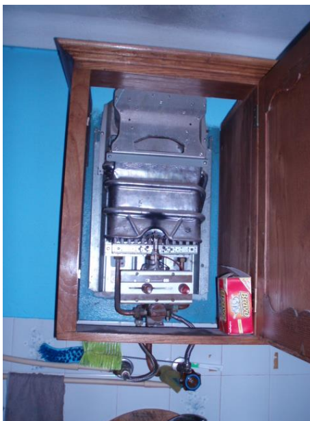
Figura 5.22 Esquentador VULCANO, modelo W250 KV3, no caso de estudo 2.
