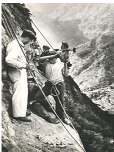
Figura 8 - Construção das Levadas
