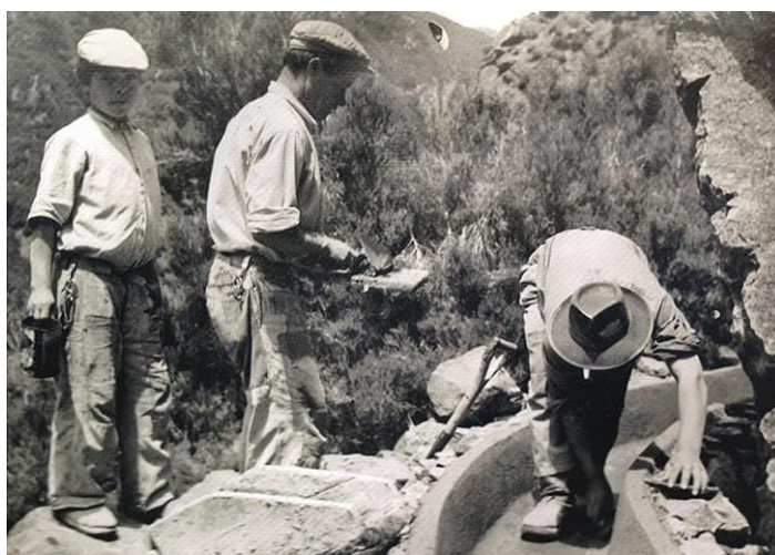
Figura 9 - Construção das Levadas
