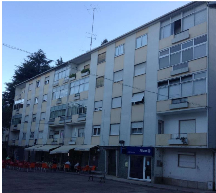
Figura 3 - Fachada principal do edifício em estudo
