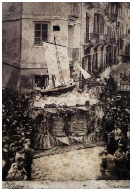
Figura 11 Falla de la calle Maldonado, foto Derrey (1889)
