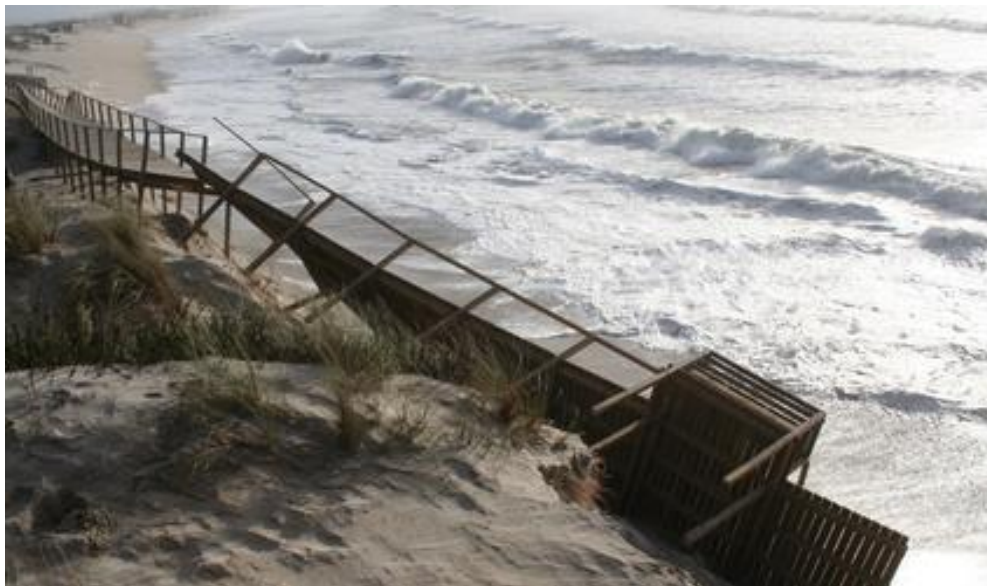
Ilustração 33- Desabamento de um passadiço na praia da Barra. Fonte: Diário de Aveiro. Foto tirada por Joaquim Soares em fevereiro 2014.
