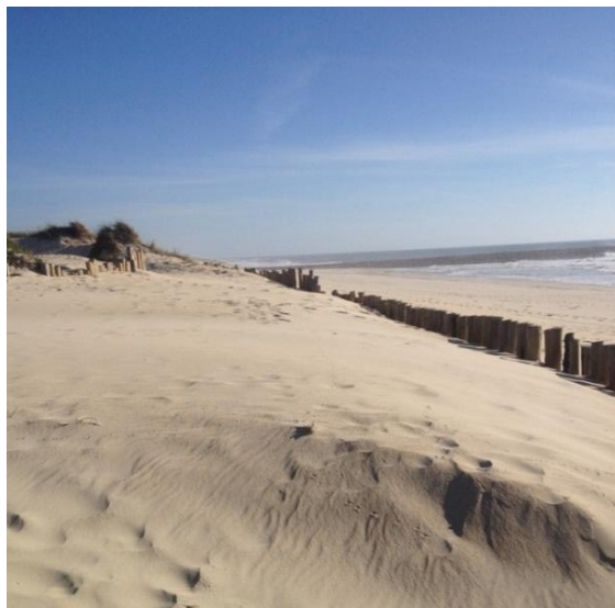
Ilustração 39- Acumulação de areias devido à ação do vento e presença de estacas. Foto tirada em 02/05/2014
