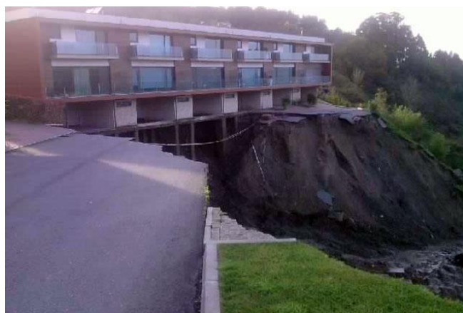
Ilustração 15- Deslizamento de terra em Guimarães afeta condomínio. Fonte: Jornal de Notícias (02/04/2013)
