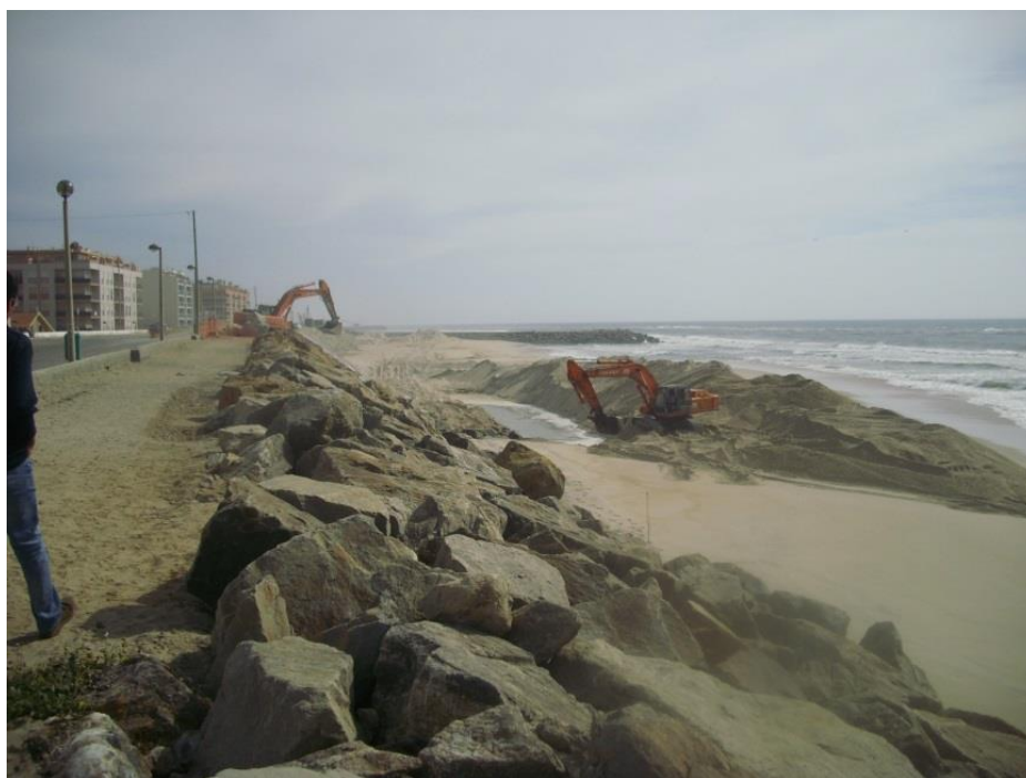
Ilustração 34- Obra de reabilitação na praia da Vagueira (afundamento da fundação). Foto tirada em: 20/05/2009. Fonte: (Coelho, 2014).
