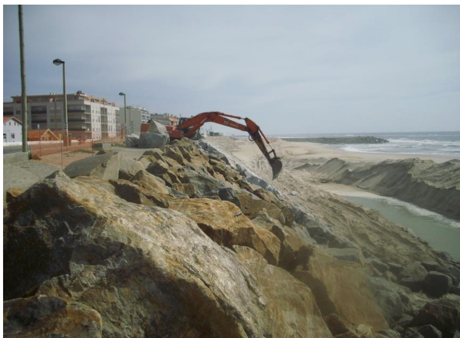
Ilustração 36- Obra de reabilitação na praia da Vagueira (afundamento da fundação. Fonte: Coelho (2014)
