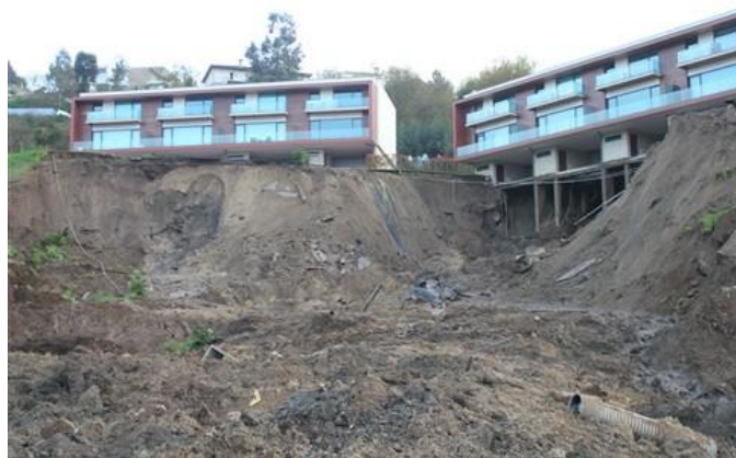
Ilustração 14- Deslizamento de terra em Guimarães. Fonte: Jornal de Notícias (02/04/2013)
