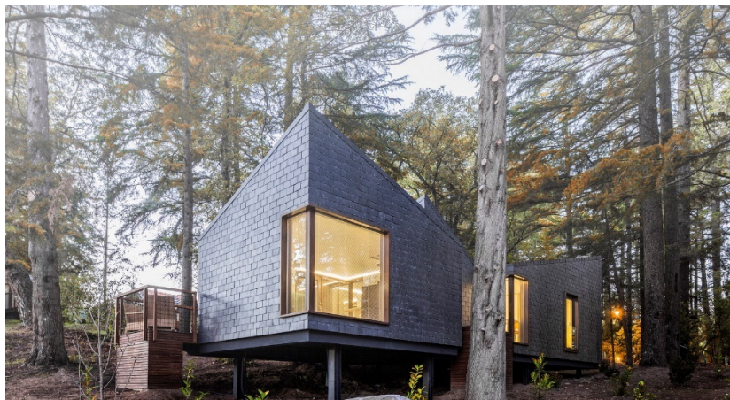
Figura 10- Revestimento externo em Ladrilhos de ardósia, seguindo as tradições construtivas da região. [21]
