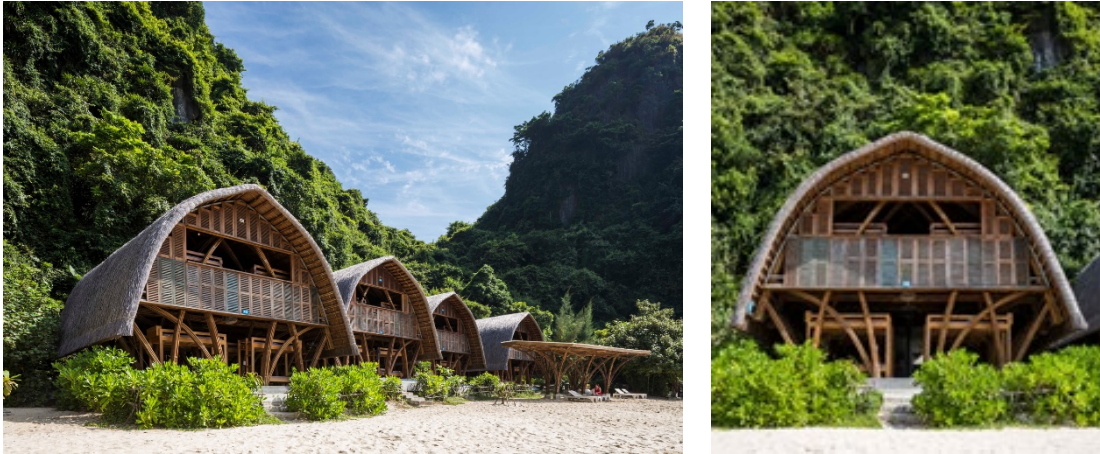
Figura 27- Cabanas habitacionais onde se pode observar as persianas de madeira reciclada, a estrutura em bambu e o telhado revestido de palha [25]
