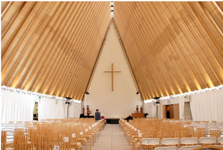
Figura 6- Estrutura de uma capela a partir da utilização de cartão prensado, projeto de Shigeru Ban [17]
