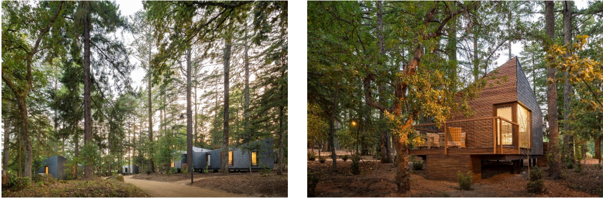
Figura 9- Eco-resort do Parque Pedras Salgadas, habitações modulares[21]
