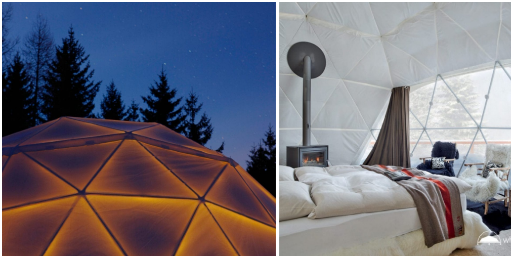
Figura 20- Forma geodésica das cápsulas com a sua estrutura esférica constituída por uma rede de triângulos, vista externa (à esquerda) e do interior (à direita)
