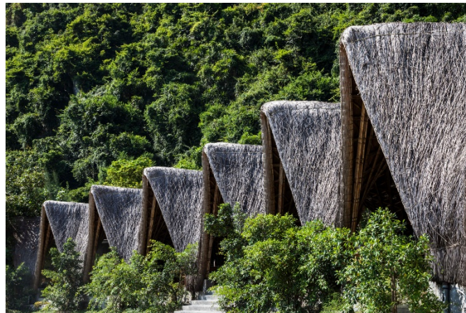
Figura 24- Telhados de estrutura em bambu e revestidos por palha [25]
