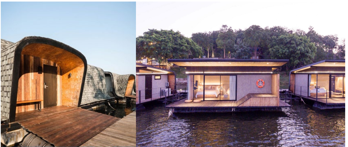
Figura 30- Vista frontal e traseira dos módulos habitacionais, em maior pormenor [26]
