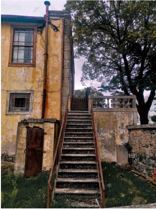
Figura 134 Fotografia das escadas do bloco de escritórios
