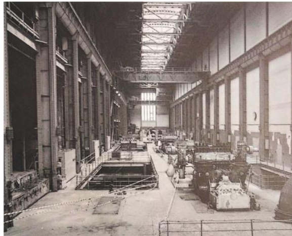
Figura 80 Fotografia da sala de Turbinas da antiga central (Cardenete Pradillo, Irene)
