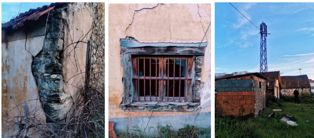
Figura 140 Fotografia de pormenor dos vários “layers” de construção
