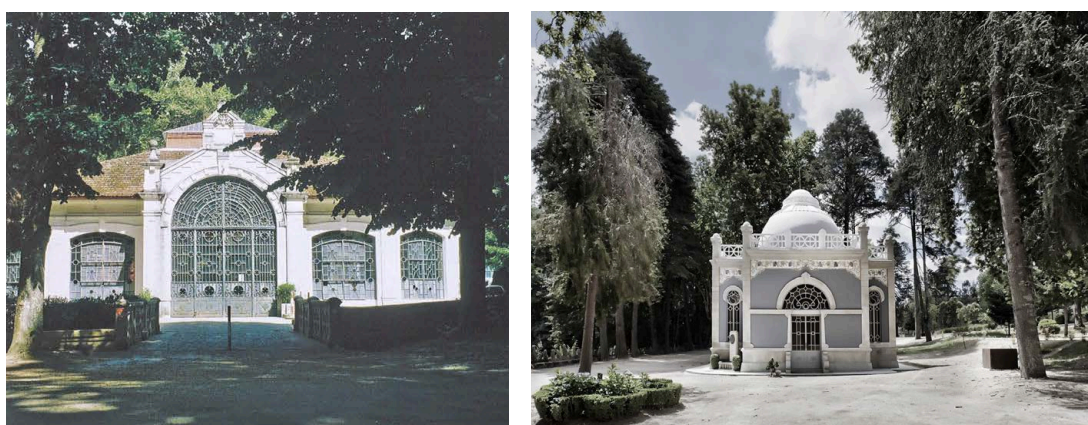
Figura 9 - Pavilhões de nascente das Termas de Melgaço e das Termas de Vidago • (Mangorrinha e Pinto, 2009)
