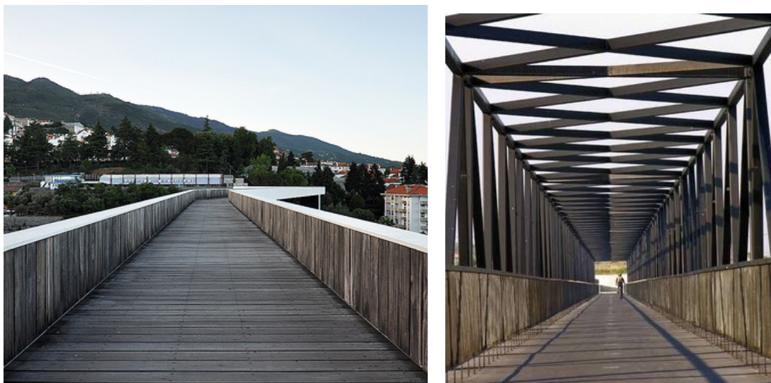
Figura 14 - a) Ponte na Covilhã; b) Ponte sobre o Esteiro de S. Pedro, Carrilho da Graça • (Fotografias do autor, 2014)
