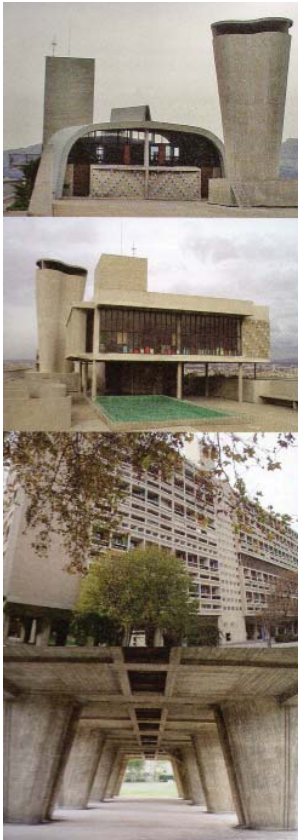
Figura 18 Unidade de Habitação de Le Corbusier, Marselha
