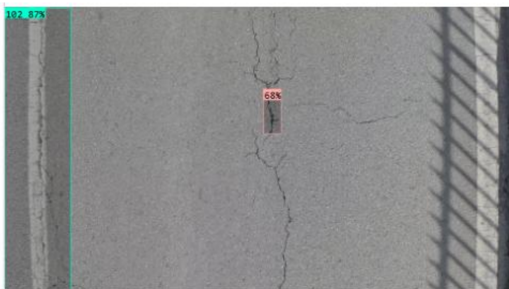
Figura 12 - Exemplo de detecção das degradações presentes numa imagem com recurso à versão 2 – Roboflow – YOLOv11
