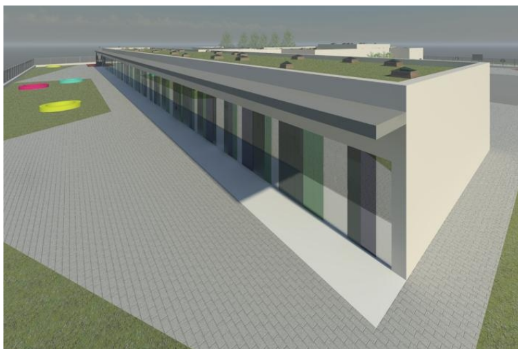
Figura 4.15: Cobertura verde do tipo extensivo
