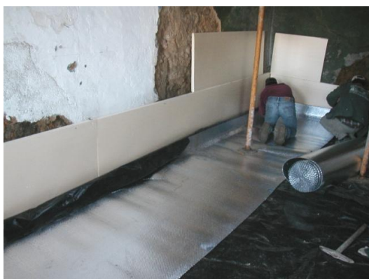
Figura 44: Execução das obras. Aplicação do filme impermeabilizante [26].
