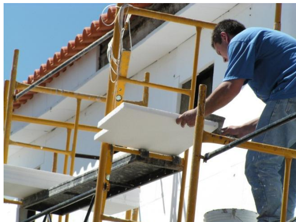
Figura 32: Exemplo de aplicação de isolamento pelo exterior, numa das casas do bairro de São Vicente de Paulo [26].
