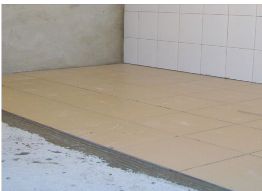
Figura 45: Execução das obras. Aplicação pavimento cerâmico numa cozinha [26].
