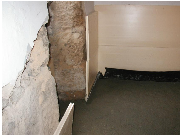
Figura 37: Execução das obras. Rebocos aplicados directamente sobre o isolamento térmico [26].
