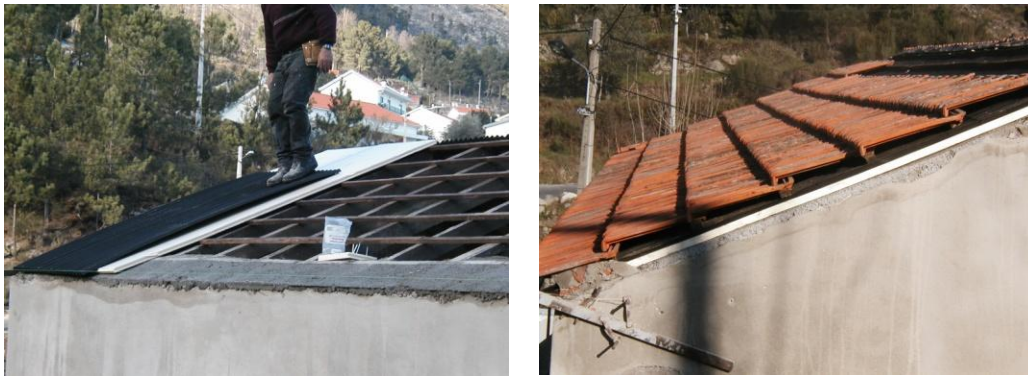
Figura 13: Aplicação do isolamento térmico e da sub-telha nas coberturas [26].
