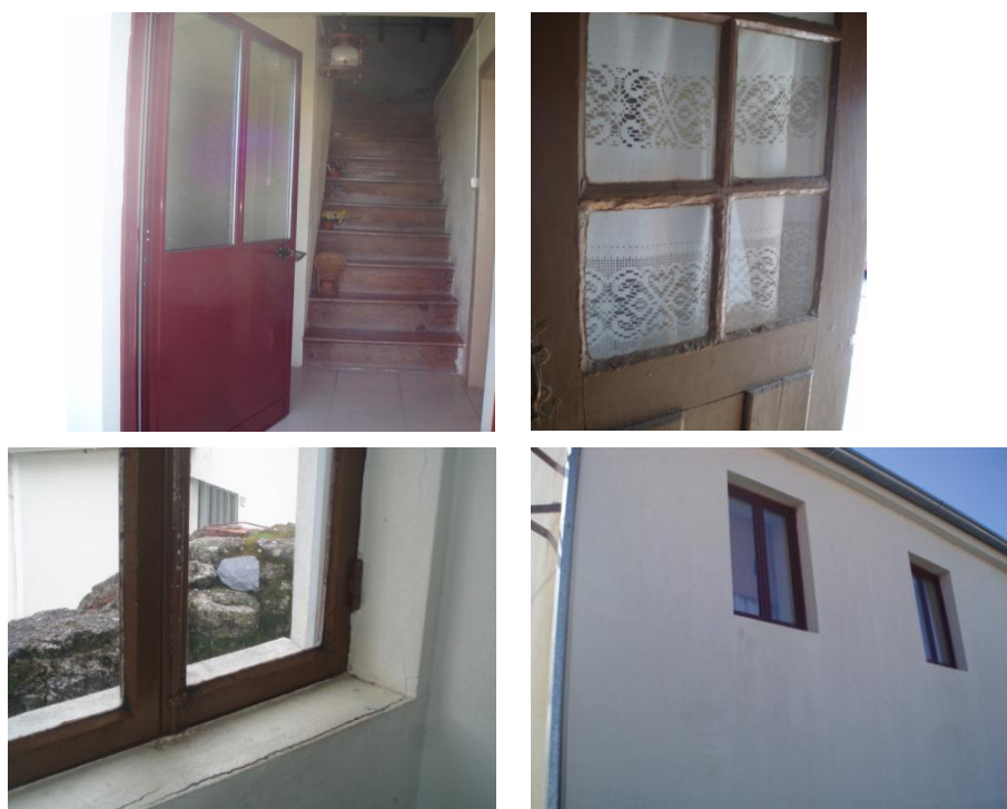
Figura 20: Exemplo de novas e antigas caixilharias (porta e janelas) no bairro de São Vicente de Paulo.
