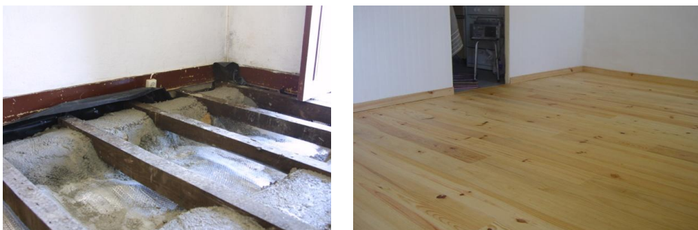
Figura 19: Exemplo da substituição do pavimento na sua totalidade [26].
