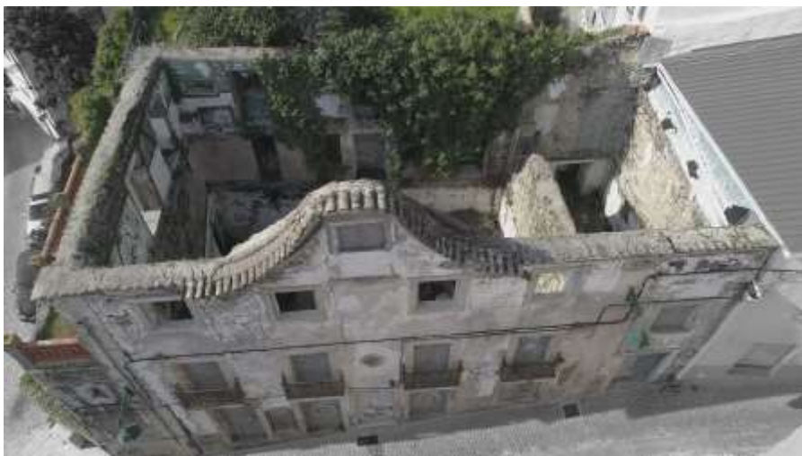
Figs.39 Levantamento fotográfico do edifício.
