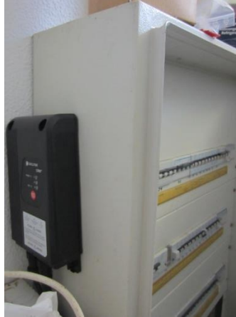
Figura 4.3 - Colocação do analisador de energia.
