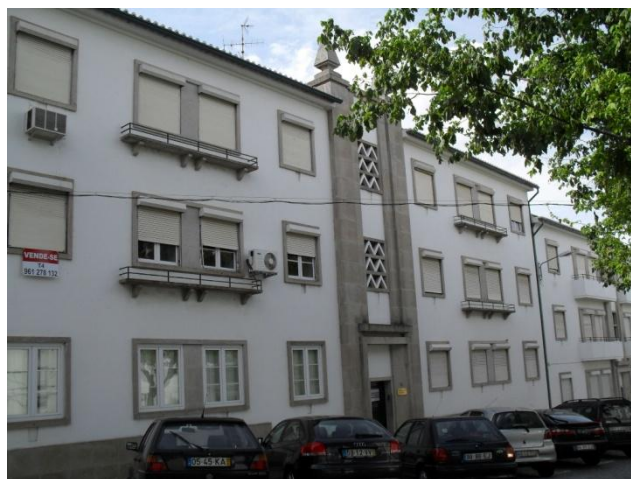
Fig. 98 Bairro da Estação - 1ª fase, vista da entrada. Fonte: Paula Abreu
