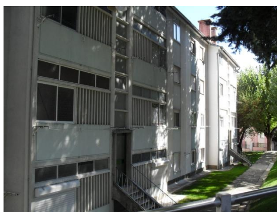
Fig. 102 Pormenor de escadaria de entrada, Fonte: Paula Abreu
