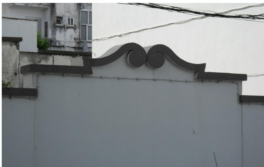
Fig. 75 Pormenor das barreiras que impedem a entrada no quarteirão, Fonte: Paula Abreu
