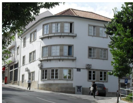
Fig. 99 Bairro da Estação - 1ª fase pormenor da fachada. Fonte: Paula Abreu
