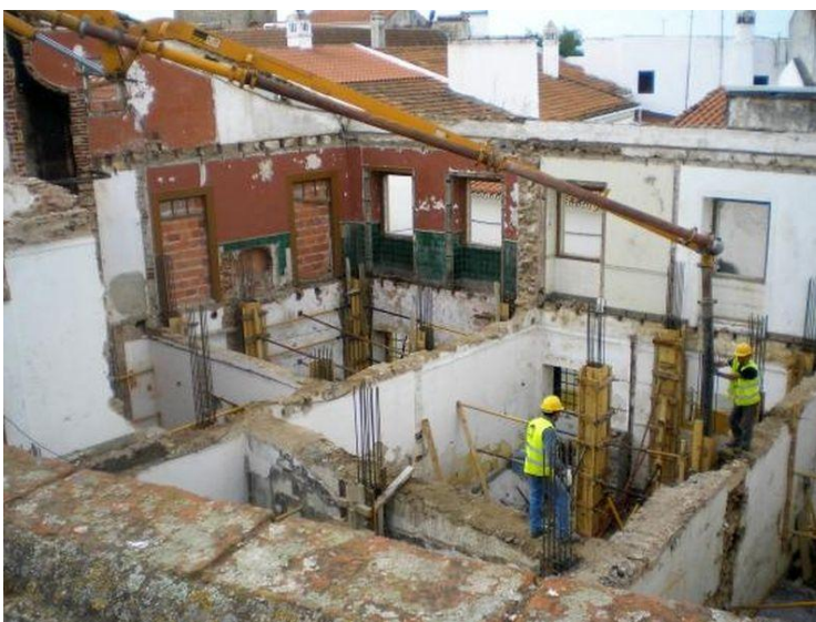
Fig.19 Reabilitação de um edifício, Alter do Chão. Fonte: http://www.planirest.pt/wp-content/uploads/2009/09/Reabilitação-de-edifício-em-Alter-do-Chão.jpg
