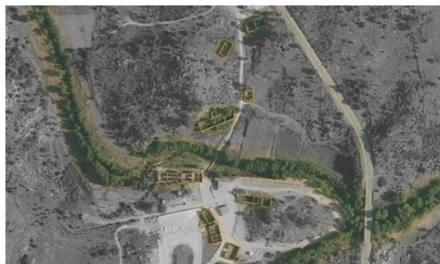
Figura 13 - Edifícios em ruínas do parque termal do Cró (Adaptado: orto foto 13 de 2007)
