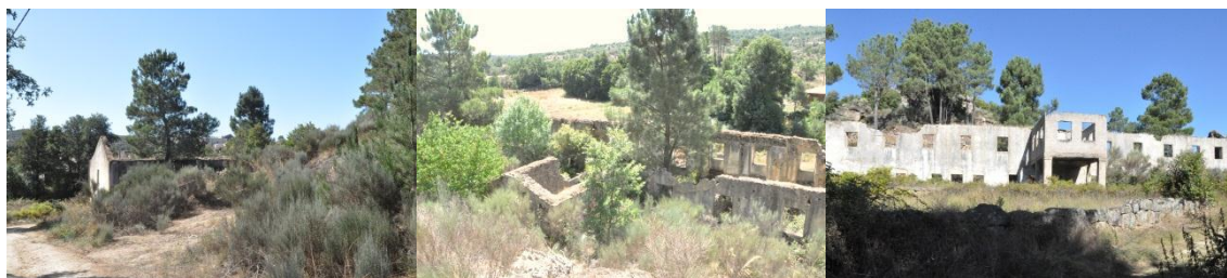
Figura 15 - Pensão Nossa Sr.ª dos Milagres em ruínas (Fonte: Autor, 2012)
