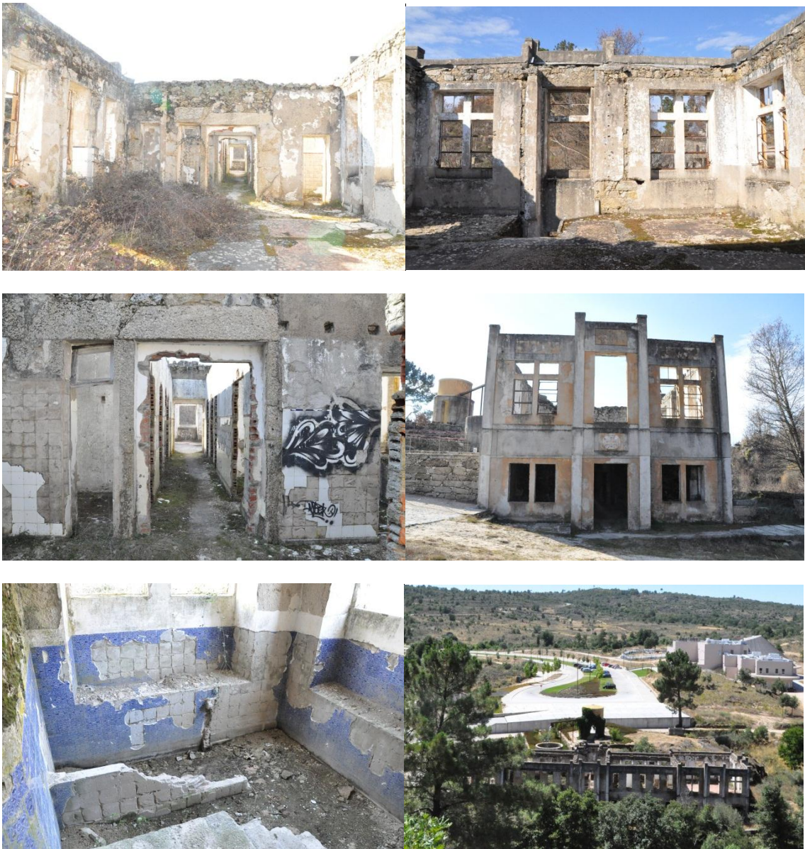
Figura 44 - Imagens do antigo balneário termal em ruínas, (Fonte: Autor, 2012)
