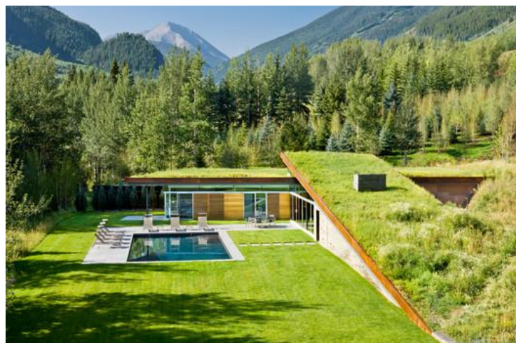
Figura 39: Casa nas Montanhas – Gluck+.
