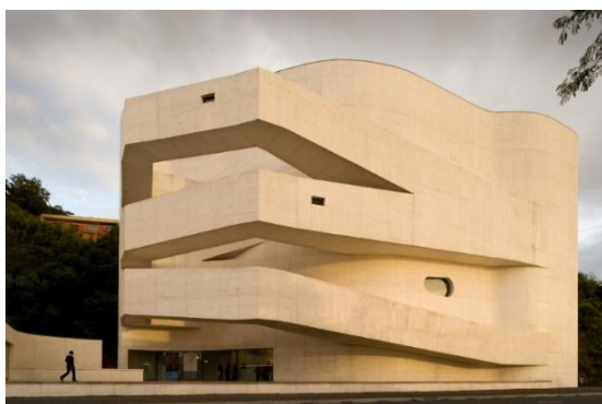
Figura 3: Fundação Iberê Camargo - Álvaro Siza Vieira.
