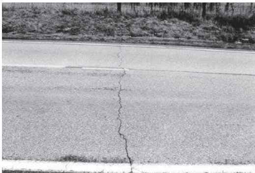
Figura 3.3: Pavimento elegível para selagem de fendas transversais (FHWA, 1999)
