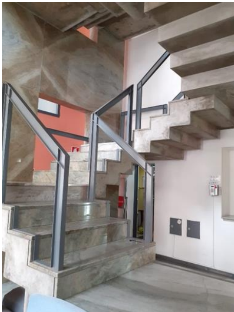
Figura 21 - Escadas de acesso principal da Sede; fotografia da autora
