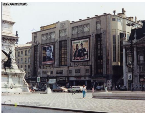
Figura 44 - Edifício pré-existente do Cineteatro Éden, Lisboa; Retirado http://www.monumentos.gov.pt/Site/APP_PagesUser/SIPA.aspx?id=6228 a 13 de novembro de 2020
