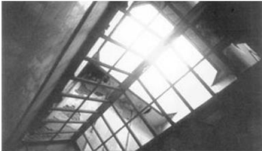
Figura 15 - Claraboia do poço de luz existente na construção original
