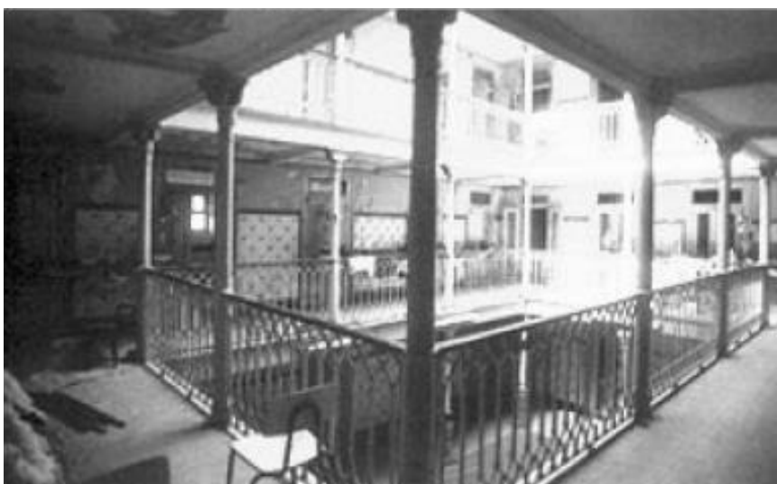
Figura 16 - Galeria de circulação existente na construção original
