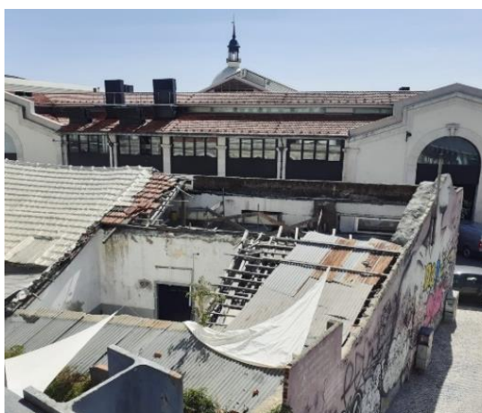
Figura 35 - Vista de parte da cobertura; fotografia da autora
