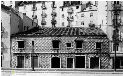
Figura 42 - Fachada existente da casa dos Bicos, Lisboa; Retirado de http://www.monumentos.gov.pt/Site/APP_PagesUser/SIPA.aspx?id=2489 consultado a 13 de novembro de 2020
