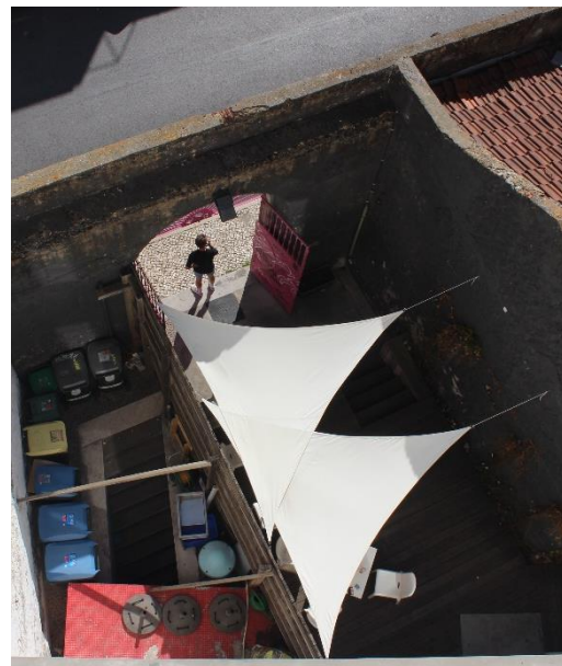
Figura 40 - Vista da entrada, do sombreamento, saída de emergência do auditório da OA fotografia facultada pela Ordem dos Arquitectos no concurso
