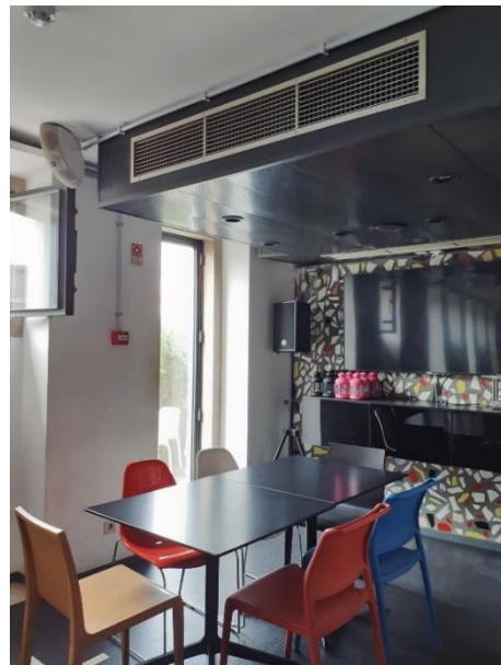
Figura 25 - Interior do bar existente; fotografia da autora
