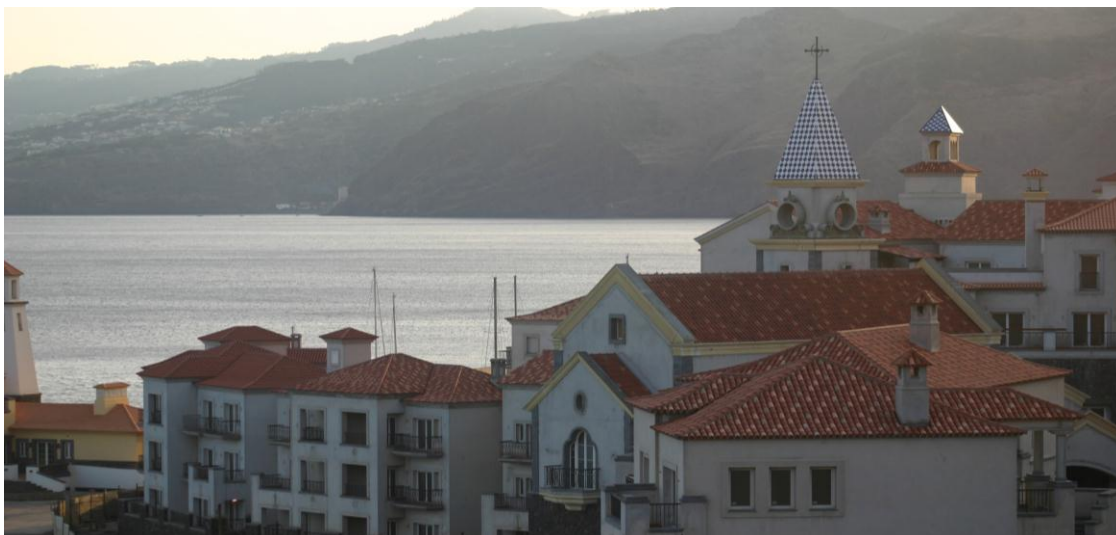
Figura 38: Vista traseira da Igreja.
