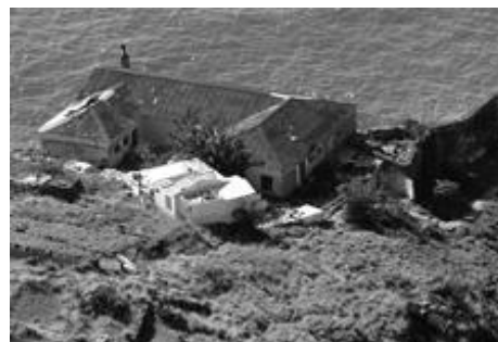
Figura 19: Vista superior do forte, (fonte: DRAC, 2001).
