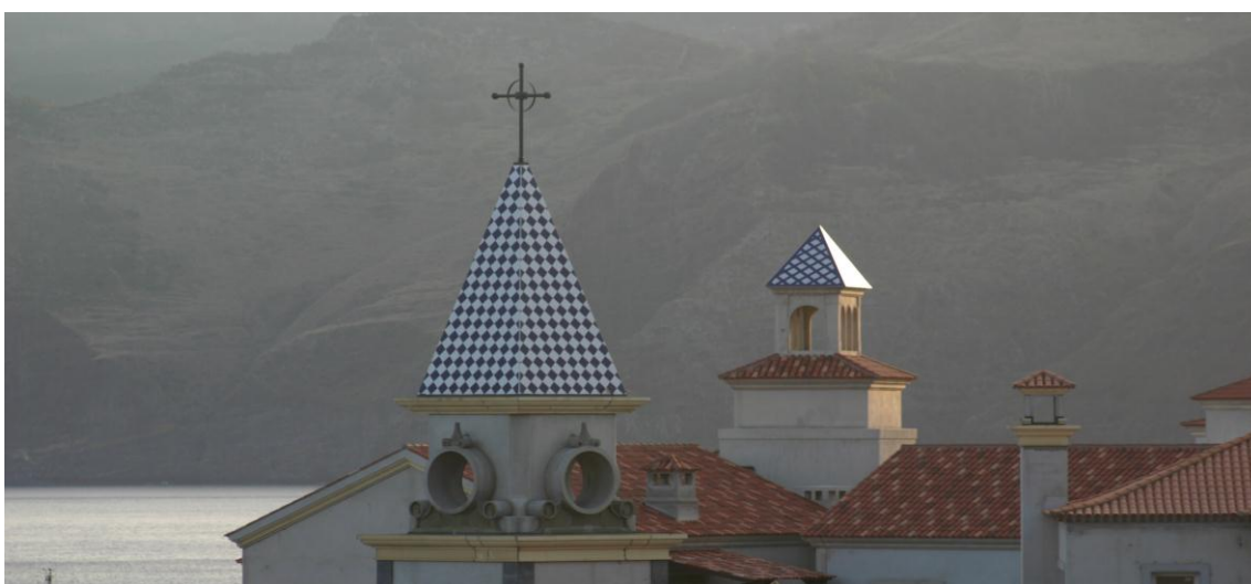
Figura 39: Vista sobre o campanário, visando materiais de coberturas.
