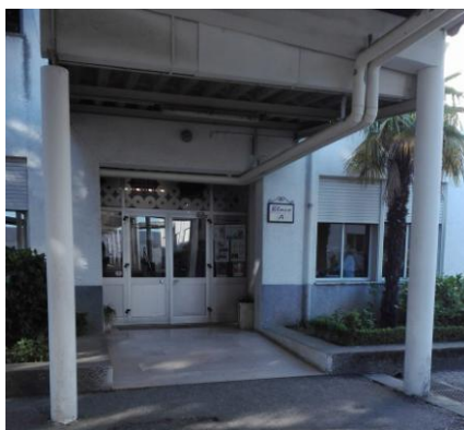
Figura 2 - Entrada do Bloco Principal (Bloco A)
