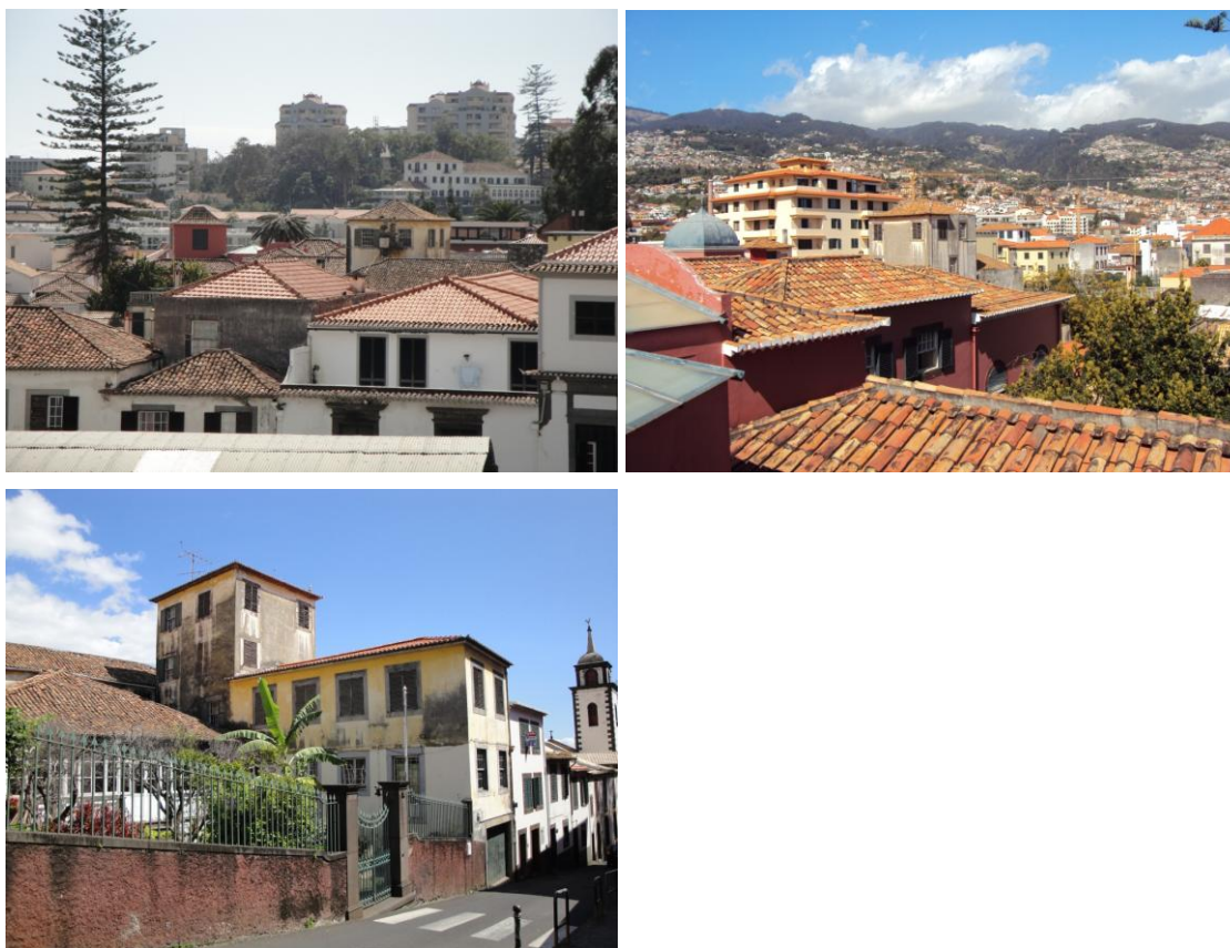
Figura 106 - Imagens do enquadramento e exterior do edifício torre (Autora)
