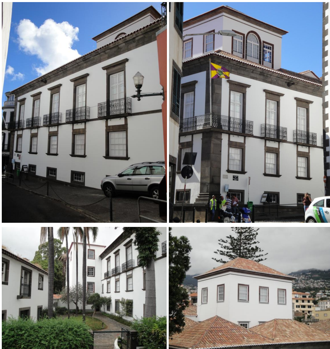
Figura 113 - Imagens do enquadramento e exterior do edifício torre (Autora)
