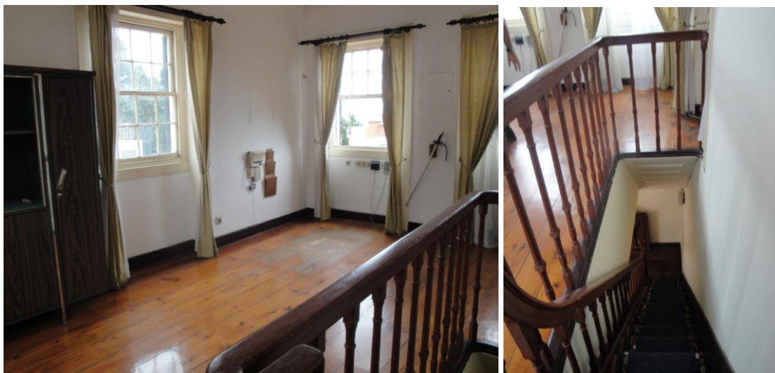
Figura 127 - Imagens do interior da torre (Autora)
