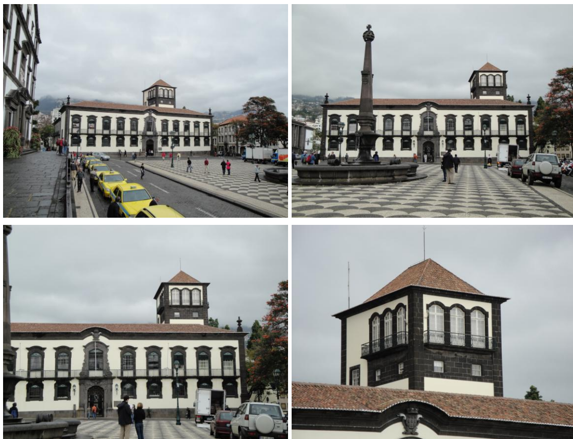
Figura 79 - Imagens do enquadramento e exterior do edifício torre (Autora)
