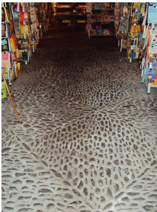
Figura 33 - Pavimento de antiga loja em calhaus rolados formando losangos (Autora)
