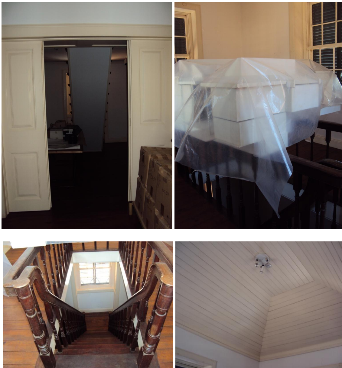
Figura 108 - Imagens do interior da torre (Autora)
