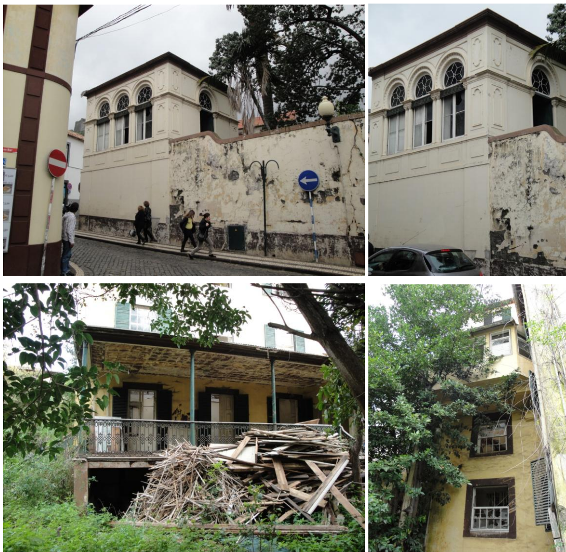
Figura 124 - Imagens do enquadramento e exterior do edifício torre (Autora)
