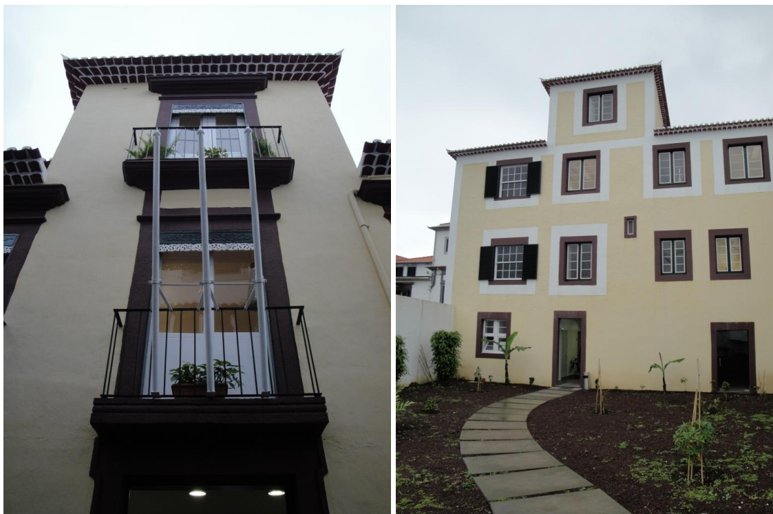
Figura 100 - Imagens do enquadramento e exterior do edifício torre (Autora)
