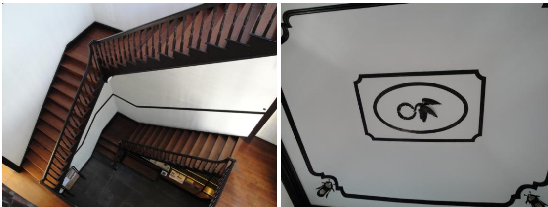
Figura 43 - Fotografias do interior da Torre (Autora)
