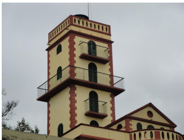
Figura 35- Torre do Instituto do Vinho (Autora)
