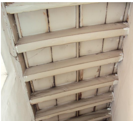
Figura 22- Pormenor estrutura da cobertura Sucursal Livraria Esperança
