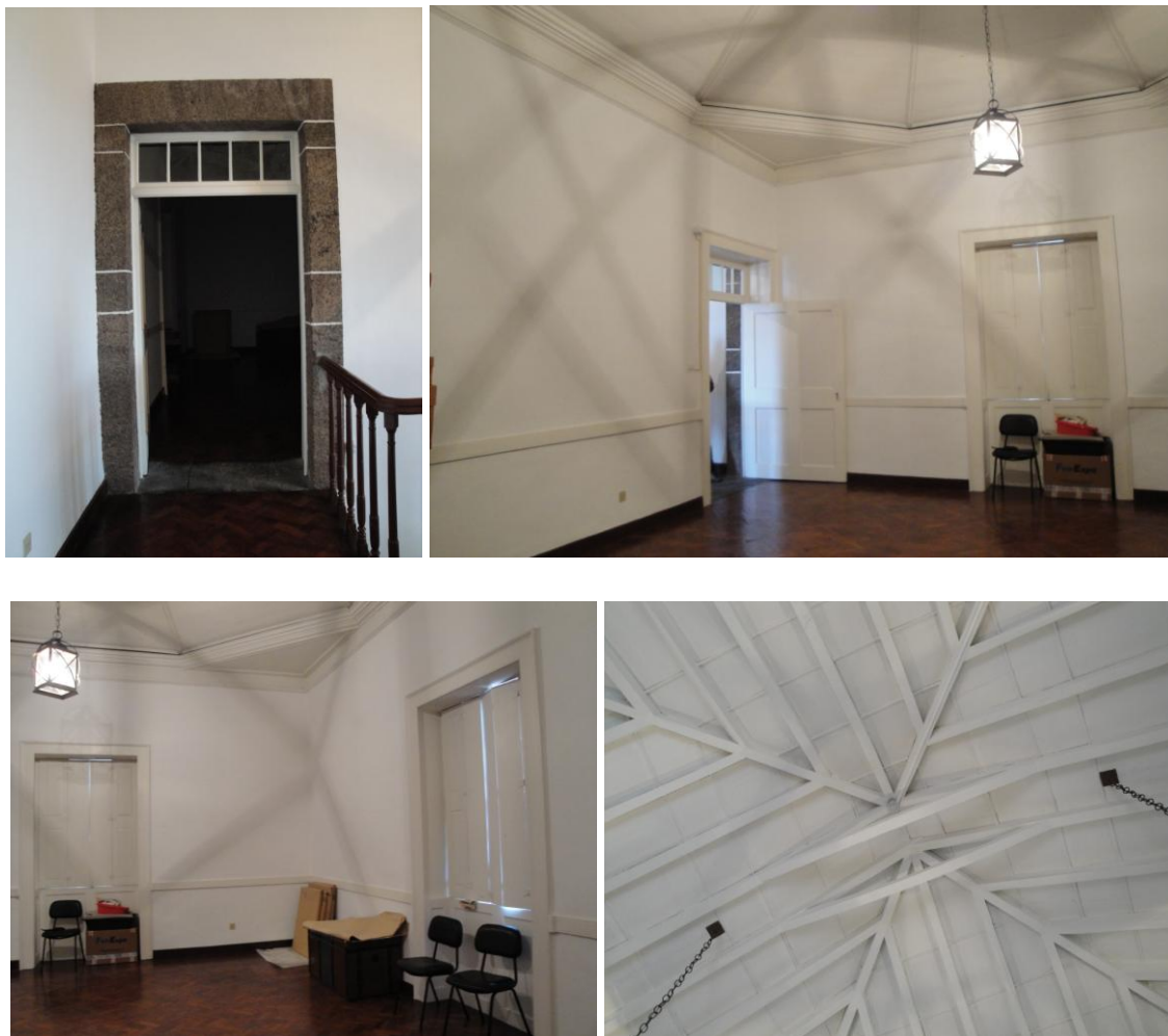
Figura 86 - Imagens do interior da torre (Autora)
