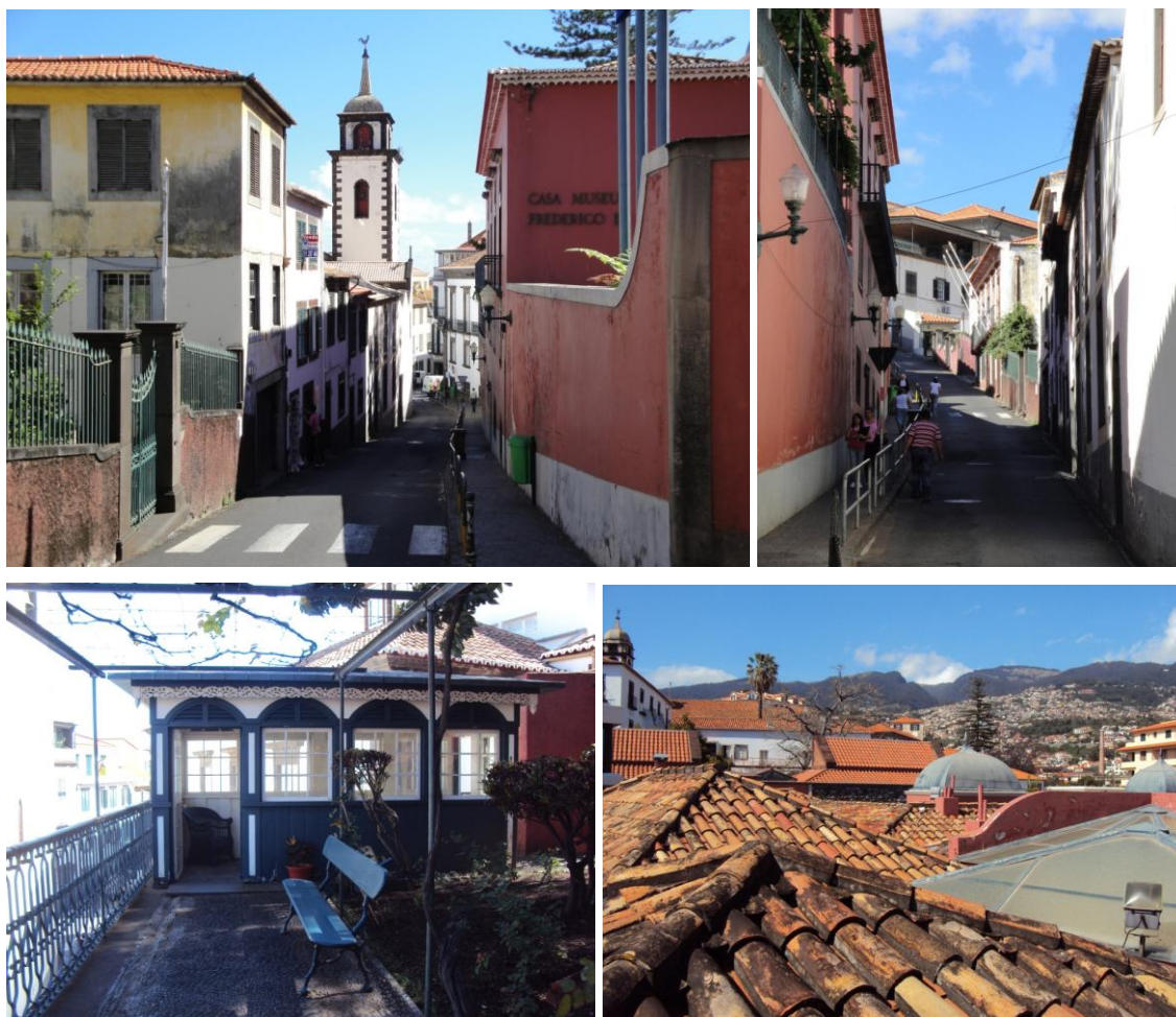
Figura 107 - Imagens do enquadramento e exterior do edifício torre (Autora)
