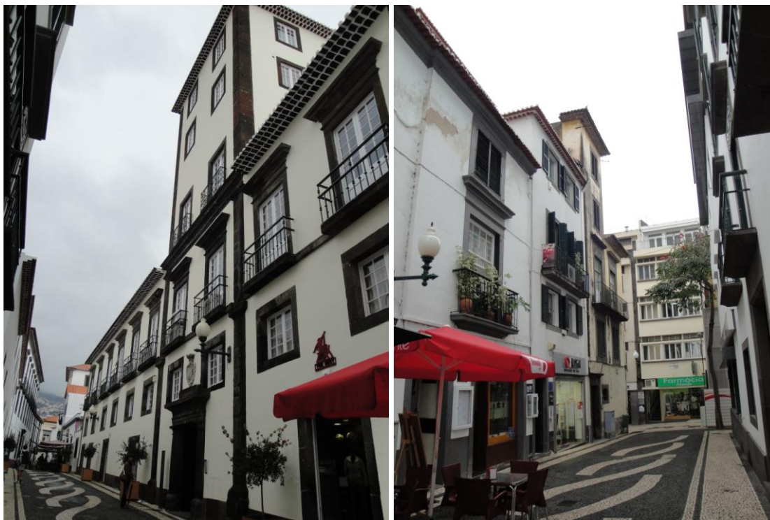
Figura 90 - Imagens do enquadramento e exterior do edifício torre (Autora)
