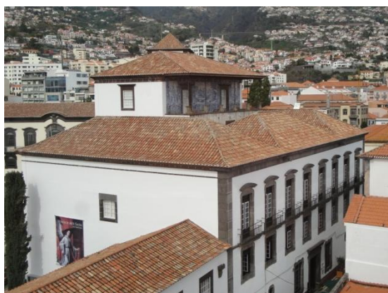
Figura Figura 21 - Pormenor de cobertura de
