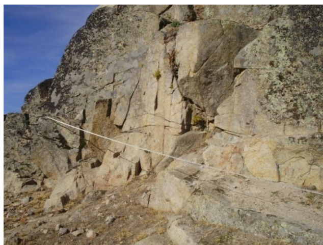
Figura 3.2 - Colocação da fita métrica de forma a determinar a fracturação do maciço rochoso (setor Oeste).
