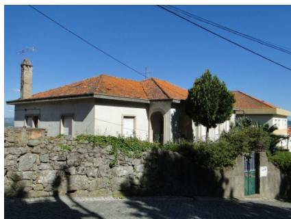
Figuras 22 - Edifício de habitação unifamiliar na área de intervenção (fonte: autor)
