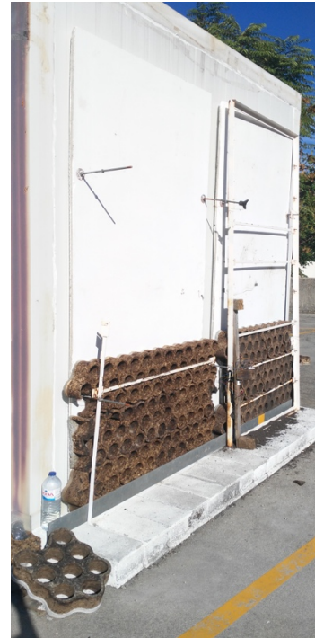
Figura 3.21-Vista exterior da câmara com os dois tipos de placas GEOGREEN
