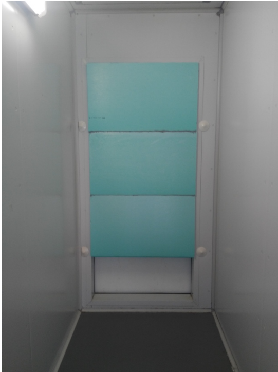
Figura 3.20-Vista interior de uma câmara com a aplicação do poliestireno extrudido
