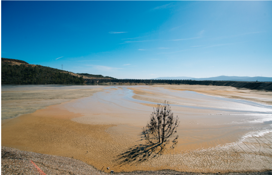
Figura 3.2-Barragem de depósito das lamas da mina da Panasqueira
