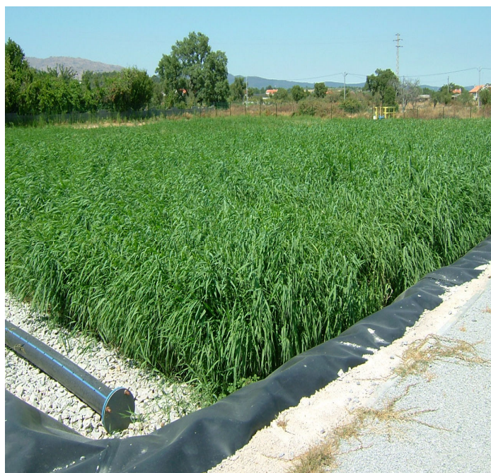
Figura 2.2 - Leito de macrófitas emergentes com escoamento subsuperficial
